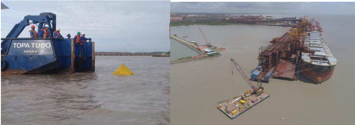
Figura 55: Lançamentos das poitas e vista aérea da balsa posicionada
