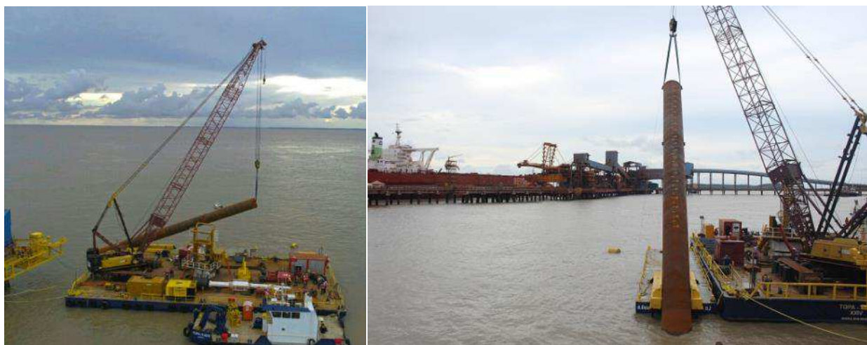
Figura 64: Verticalização da camisa metálica e deslocamento para o gabarito
