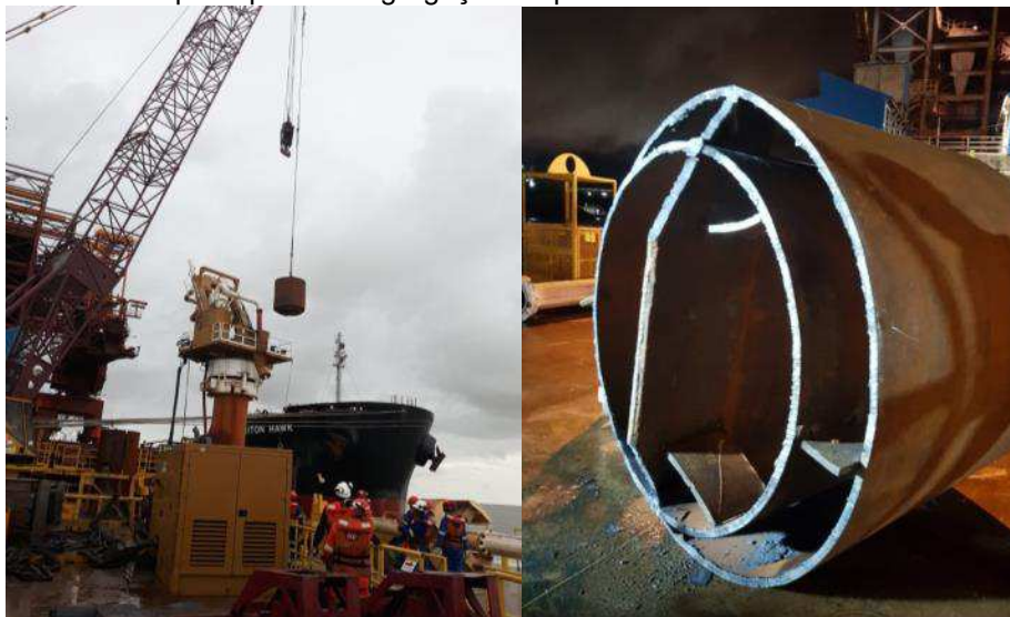
Figura 67: Içamento de trepano para desagregação de pedras sob a face da camisa e o trépano de 7 ton
