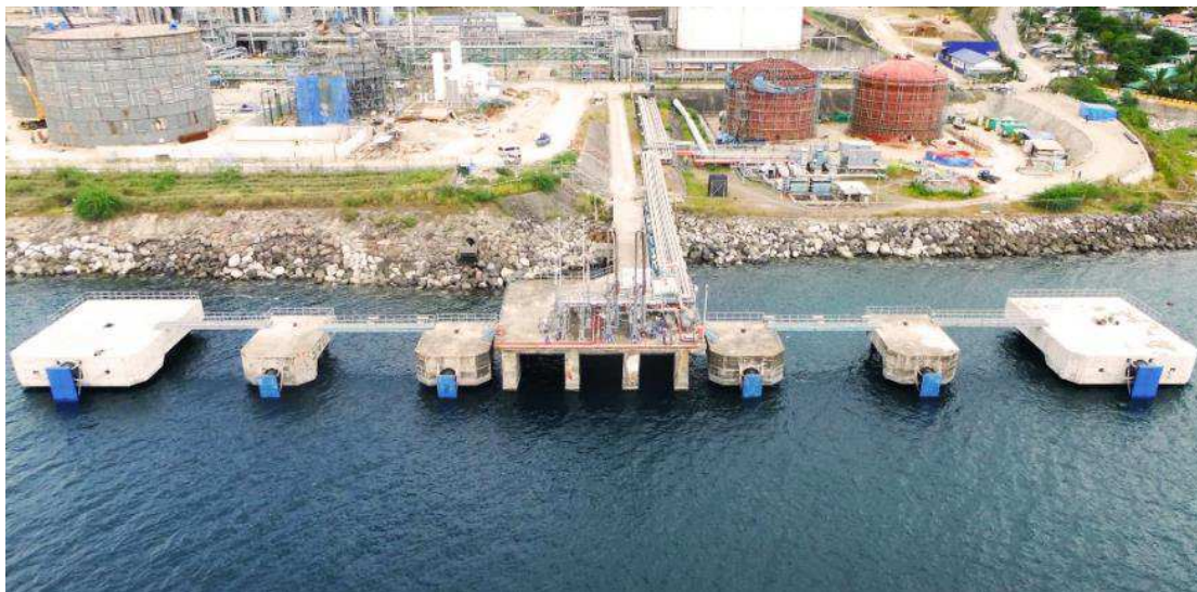
Figura 1: Dolphins de atracação e amarração no terminal da JGSOC (Navios de 54,000 – 150,000 DWT)
