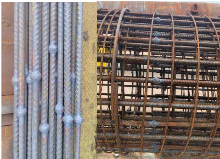
Figura 57: Soldas de topo nas barras da “gaiola”, conforme projeto 3250KP-C- 51048
