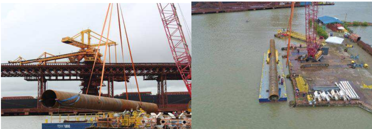
Fonte: Relatório Semanal da obra (PIACENTINI, 2019).
