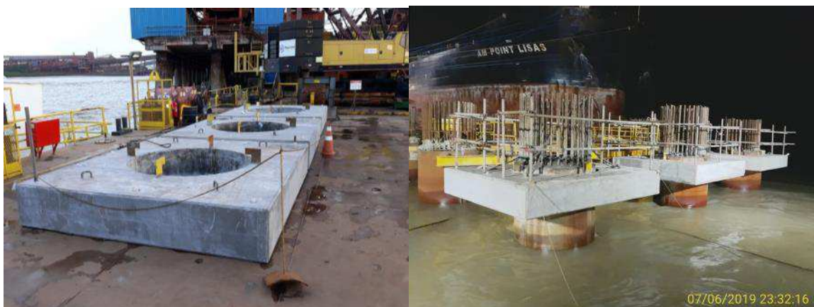
Figura 75: Capitéis aguardando transporte e após terem sido instalados
