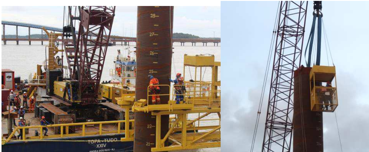
Figura 65: Travamento da camisa no gabarito e colaboradores retirando as pinças de içamento
