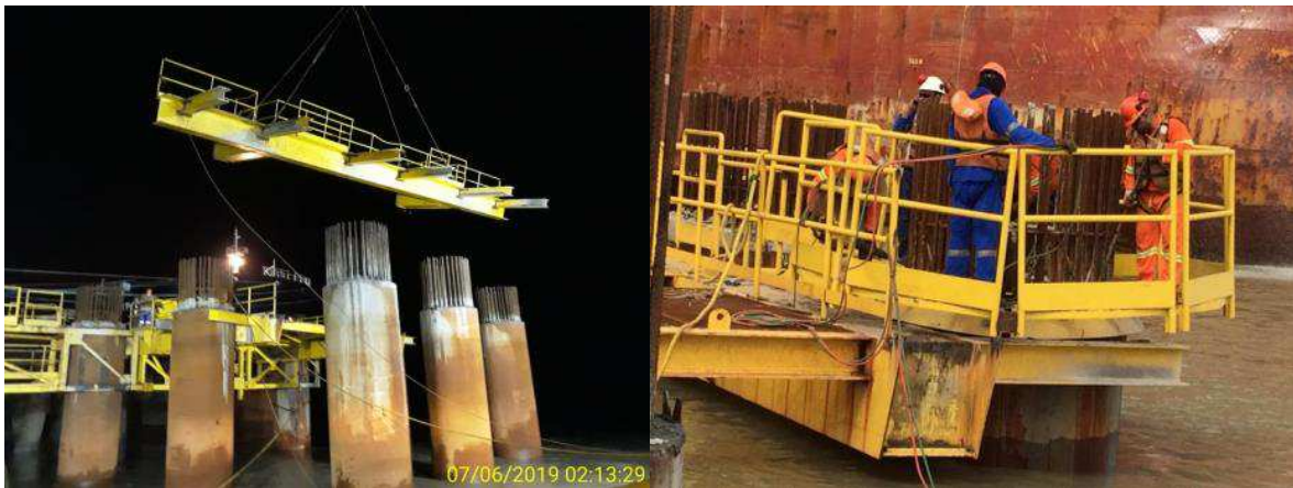
Figura 74: Processo de remoção dos gabaritos
