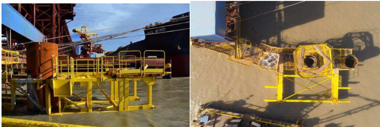
Figura 60: Montagem concluída dos módulos B1 e C
