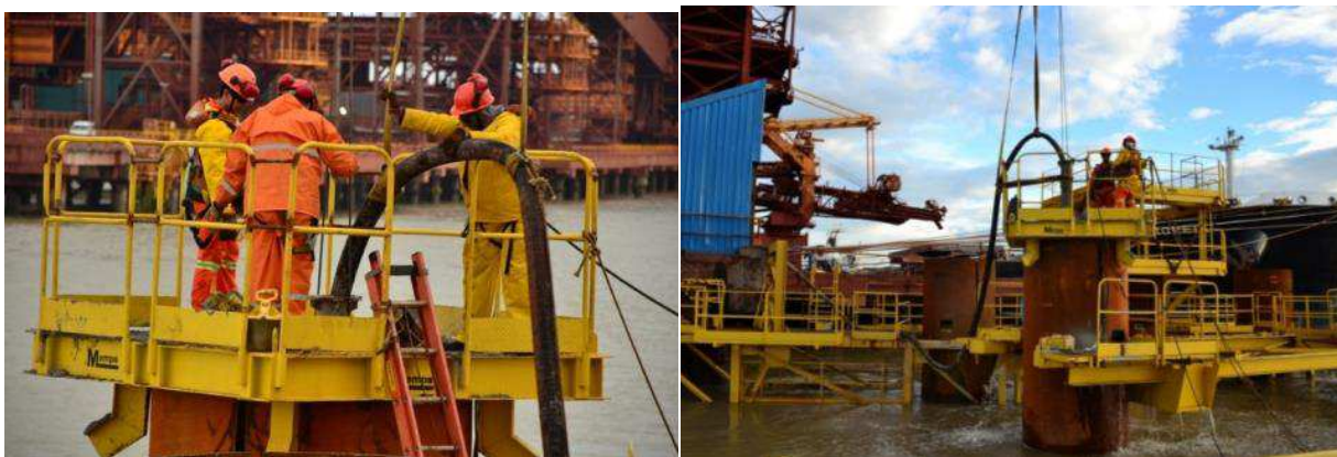
Figura 72: Realização da concretagem da estaca E07
