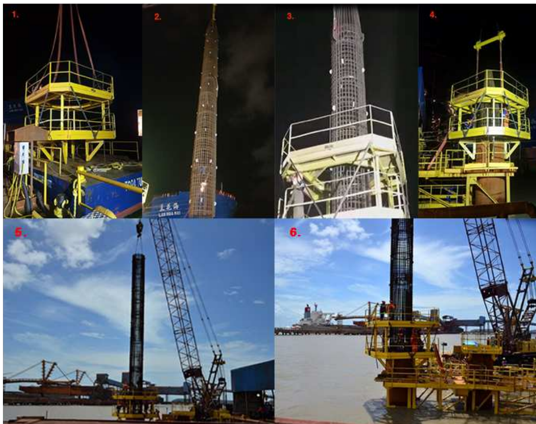
Figura 70: Instalação de Armadura
