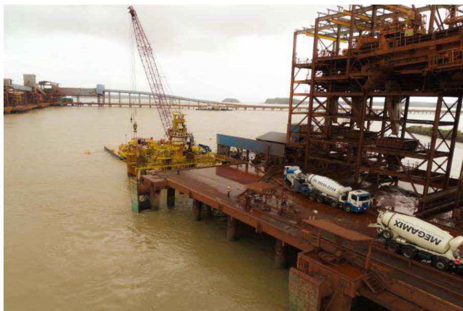
Figura 71: Concretagem da estaca E07
