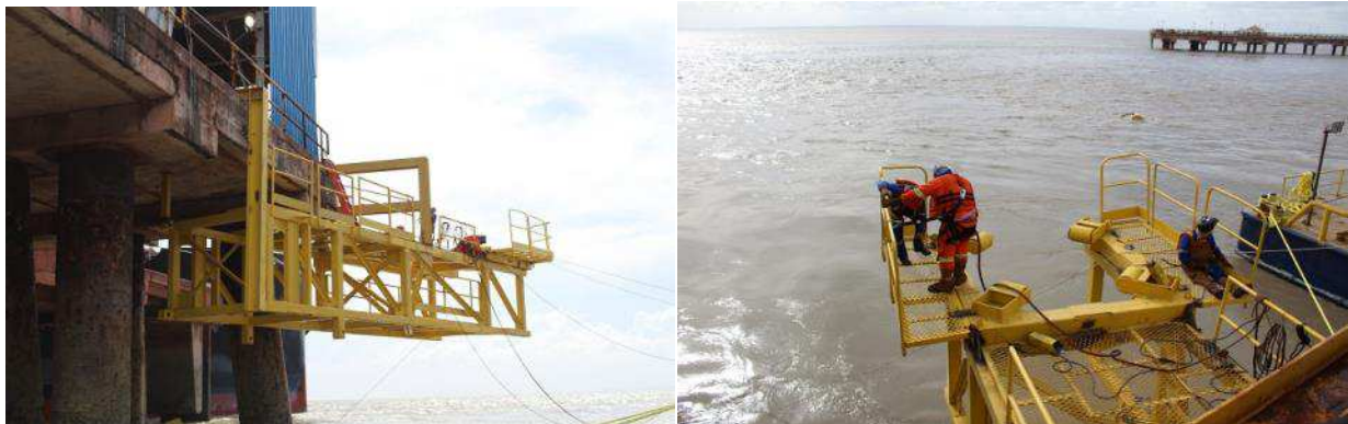
Figura 59: Processo de instalação da treliça A na estrutura do Píer III
