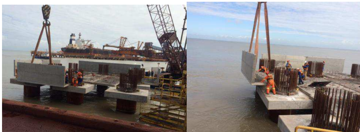
Figura 76: Locação das peças da pré-laje do dolfim
