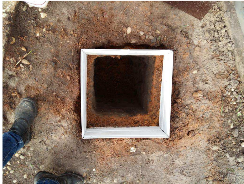
Figura 40: Escavação concluída e fôrma colocada.
