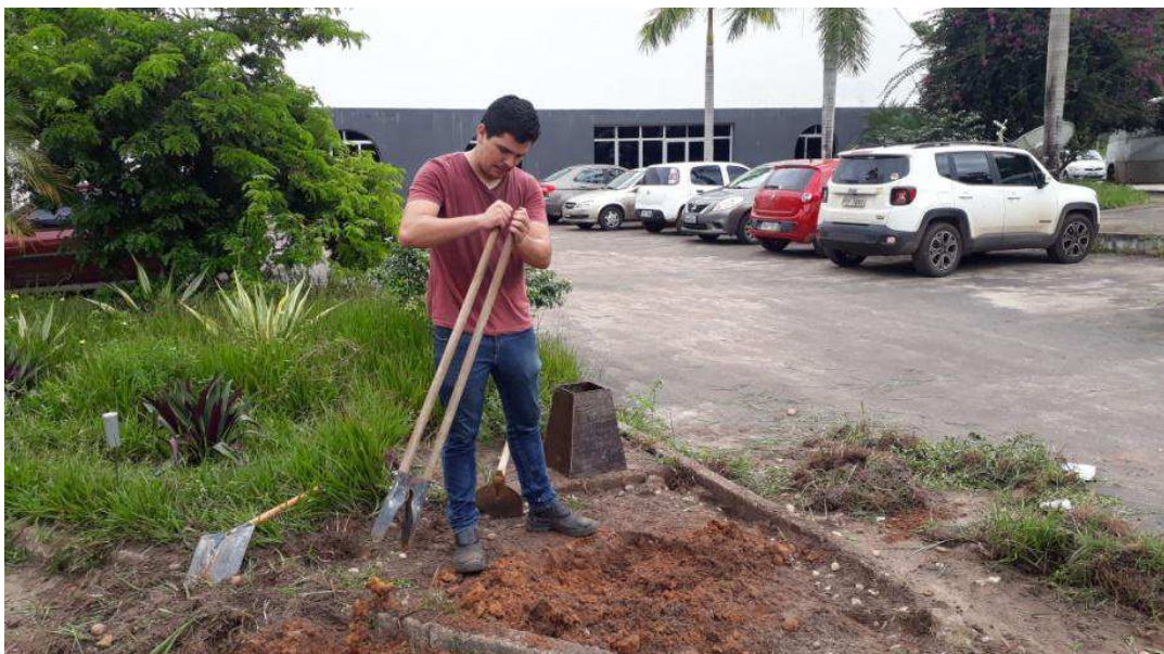
Figura 37: Limpeza e Início das Escavações
