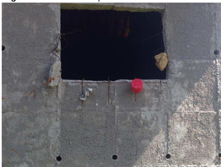
Figura 19 - Armadura exposta
