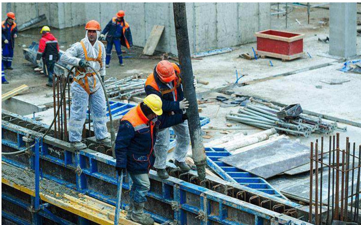
Figura 9 - Concretagem da parede de concreto
