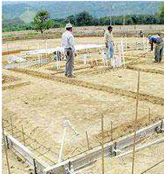
Figura 2 - Fundação tipo radier.
