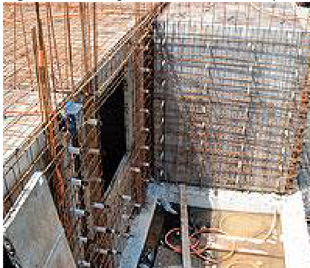
Figura 7 - Montagem das armaduras da parede
