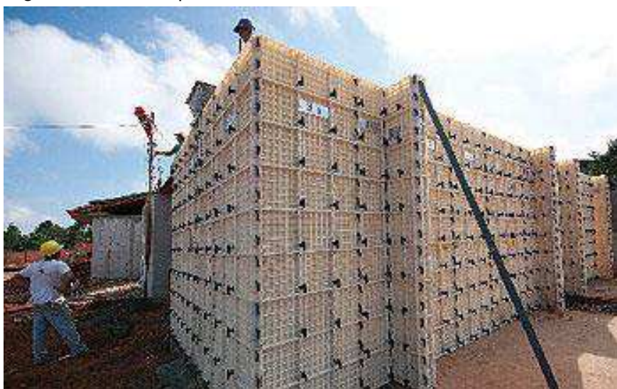
Figura 4 - Fôrmas plásticas montadas
