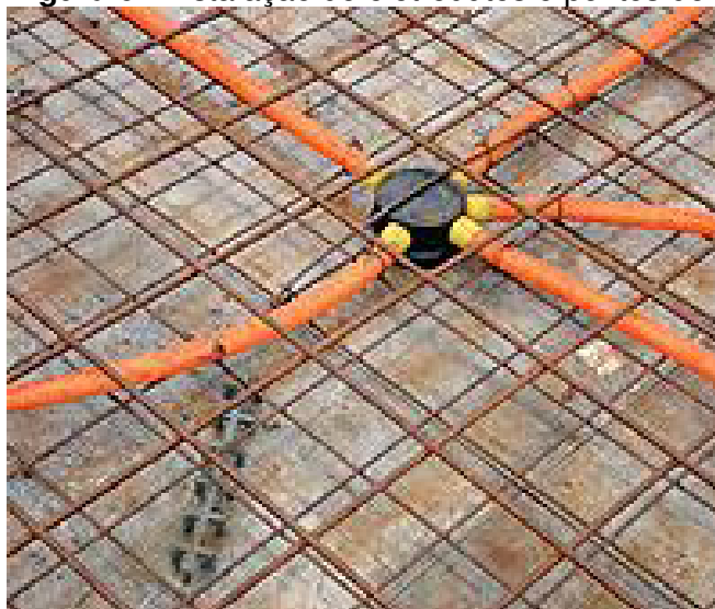
Figura 6 - Instalação de eletrodutos e pontos de luz
