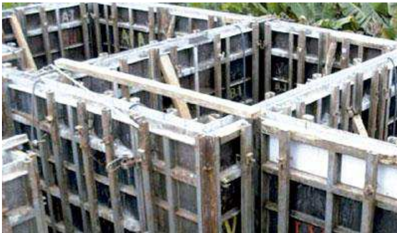
Figura 1 - Jogo de fôrmas pronto para a concretagem
