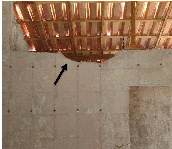
Figura 17 - Adensamento do concreto
