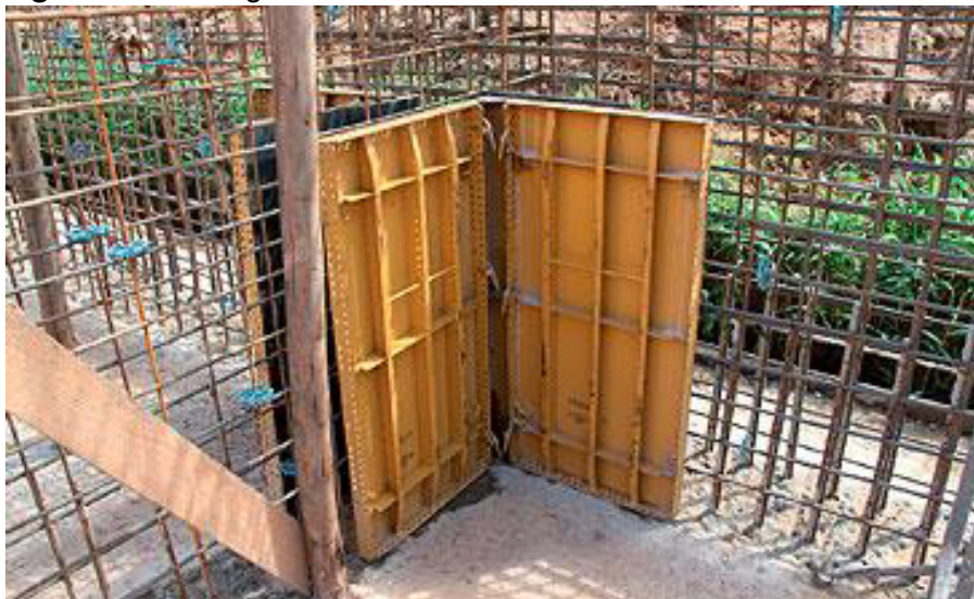
Figura 3 - Montagem das fôrmas metálicas
