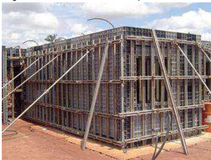
Figura 5 - Sistema de fôrmas compostas.
