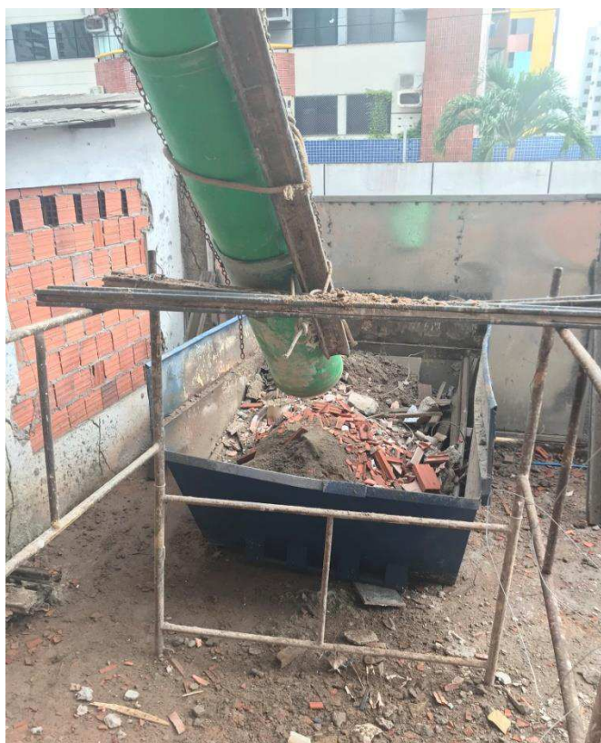
Figura 9 - Armazenamento de entulho.
