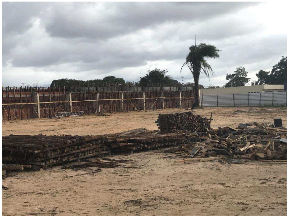
Figura 20 - Escoras de madeira.
