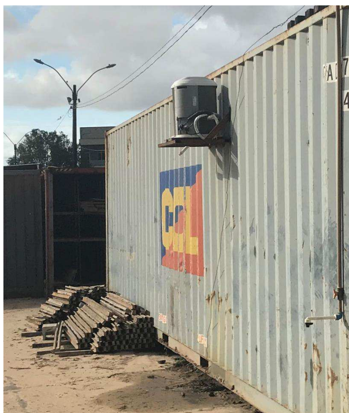
Figura 19 - Refrigeradores nos containers.
