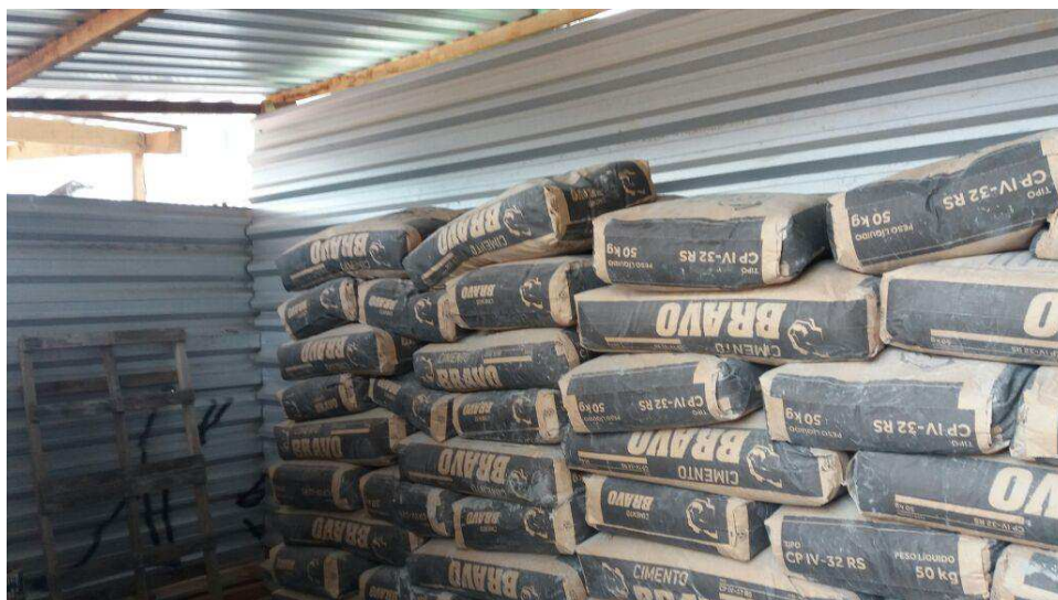
Figura 8 - Exemplo de armazenamento com pallets.
