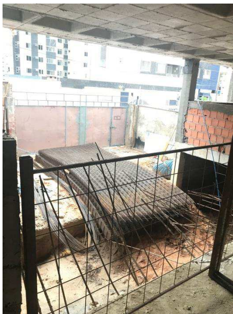
Figura 42 - Entrega de insumos no subsolo para ser armazenado no pavimento térreo.
