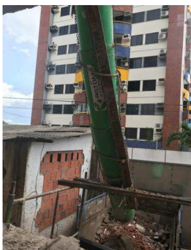
Figura 47 - Descarte de entulho por dutos.
