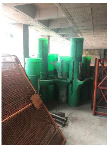
Figura 46 - Dutos de entulho prontos para uso.
