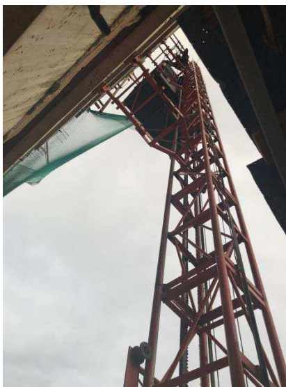
Figura 41 - Deslocamento do elevador de cremalheira para pavimento superior.
