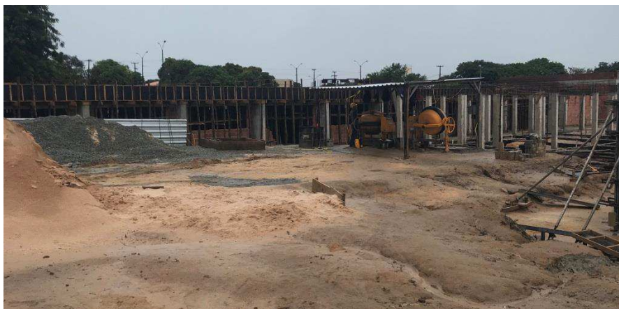
Figura 23 - Central de argamassa.
