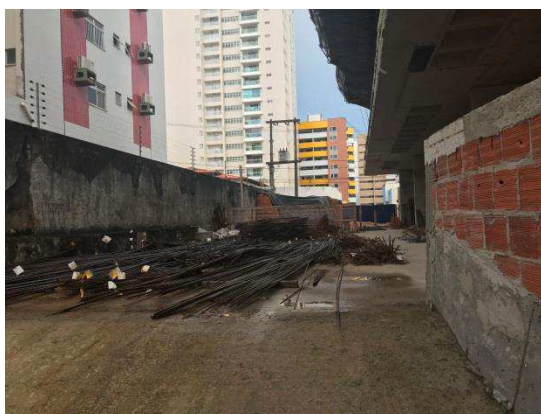
Figura 43 - Armazenamento de aço e bloco cerâmico no pavimento térreo.
