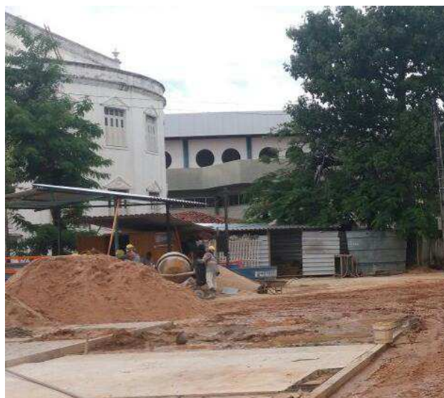
Figura 32 - Central de argamassa e armazenamento de materiais.
