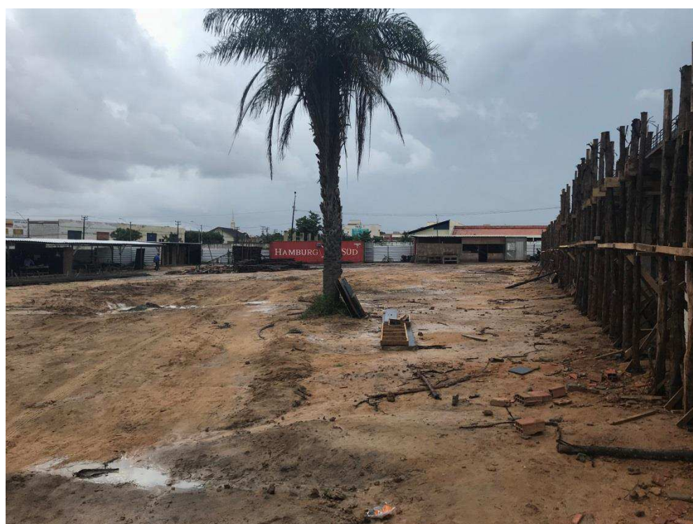
Figura 18 - Circulação canteiro obra A.
