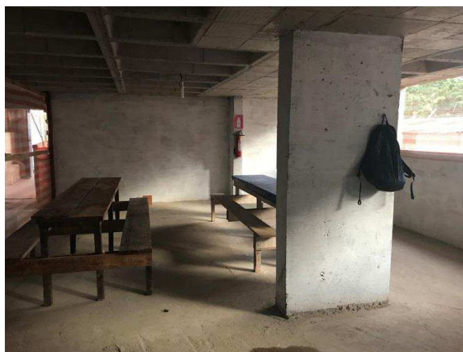
Figura 40 - Refeitório obra C.
