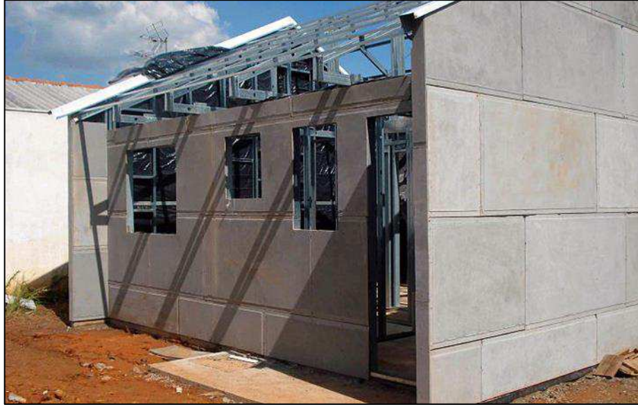
Figura 44 - Placas cimentícias instaladas como revestimento externo da edificação em Steel Frame
