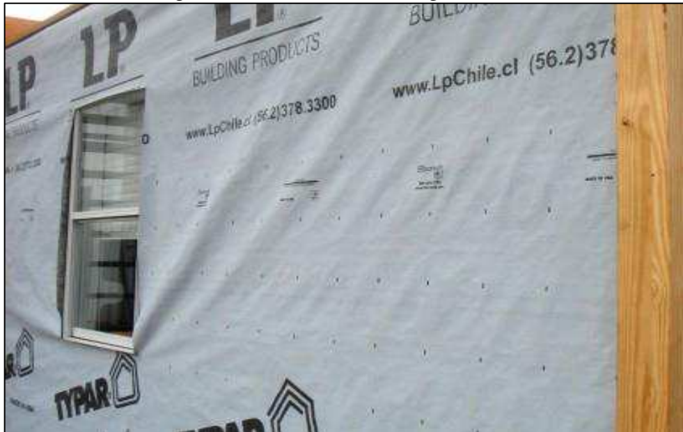
Figura 41 - Membrana hidrófuga instalada
