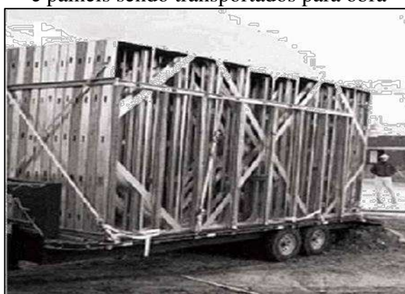
Figura 26 - Elementos estruturais como tesouras e painéis sendo transportados para obra
