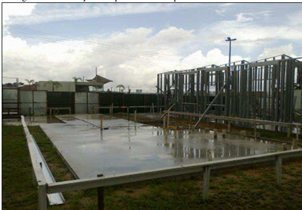
Figura 30 - Fundação do tipo Radier feito para uma obra em Steel Frame
