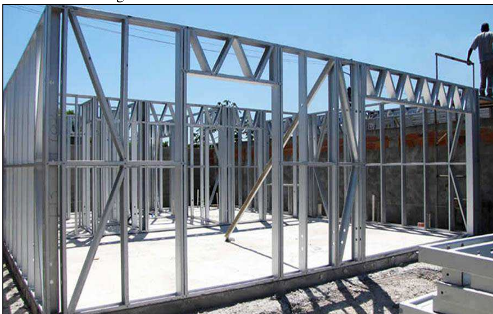
Figura 38 - Estrutura em Steel Frame montada
