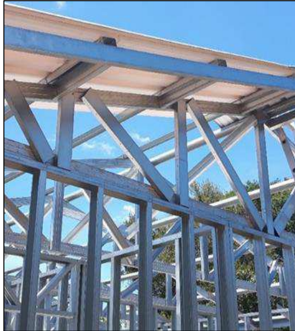
Figura 43 - Estrutura de cobertura montada conforme Sistema Steel Frame
