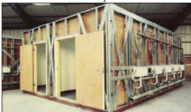
Figura 27- Elemento de construção Modular em Steel Frame
