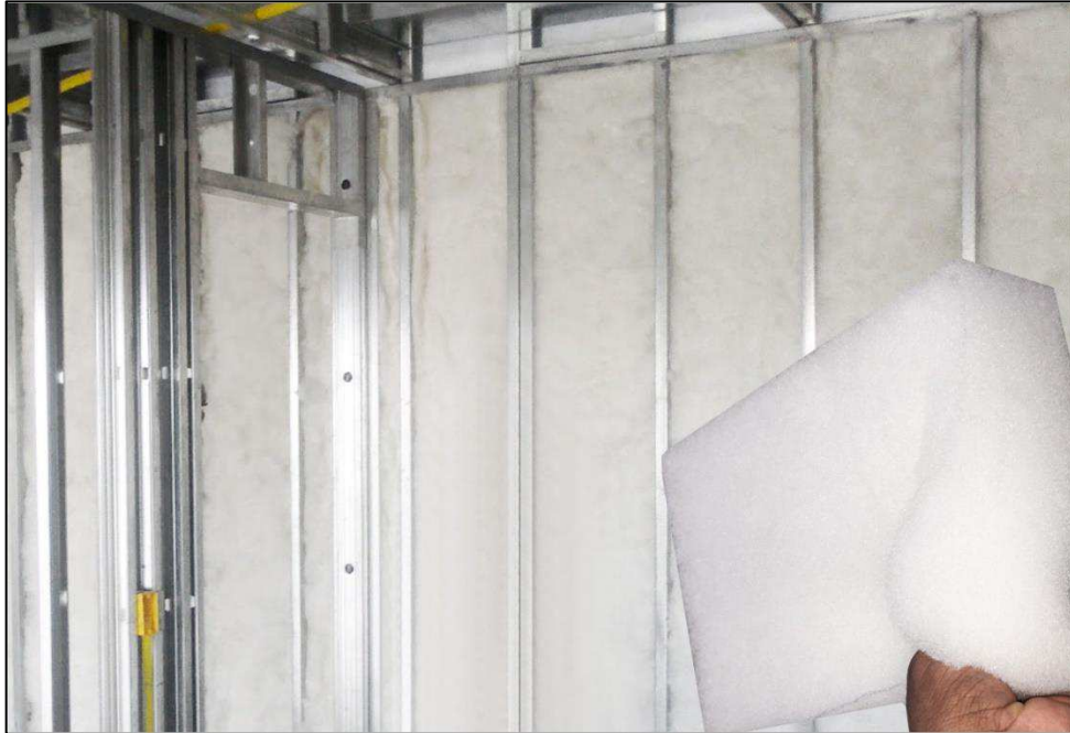
Figura 40 - Lã de Pet sendo utilizada em revestimento termo acústico
