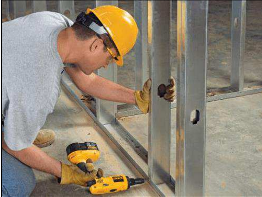
Figura 37- Montagem da estrutura de uma residência em Steel frame
