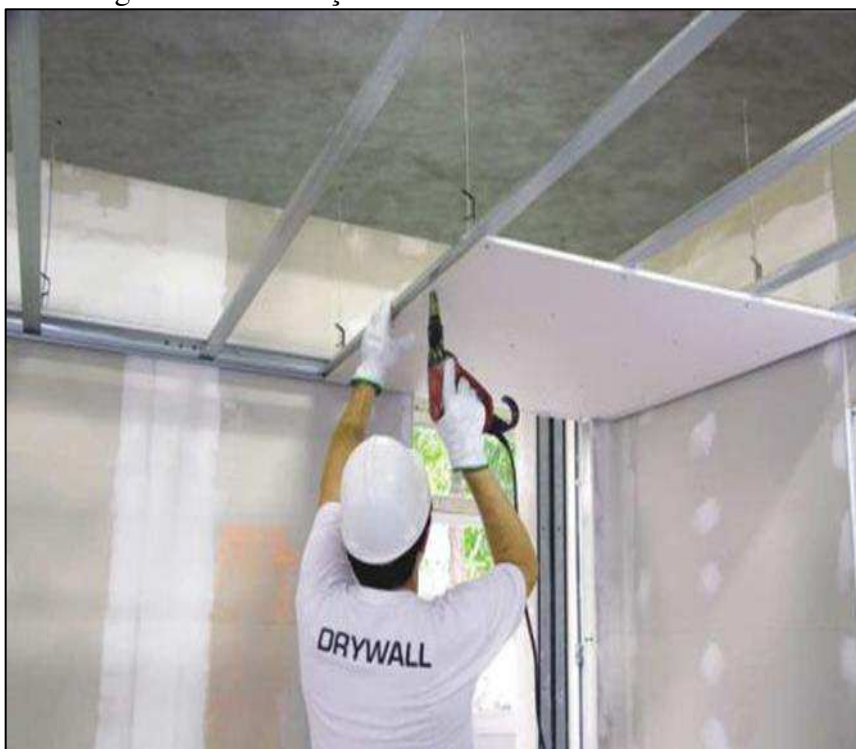
Figura 22 - Colocação de Forro em Gesso Acartonado
