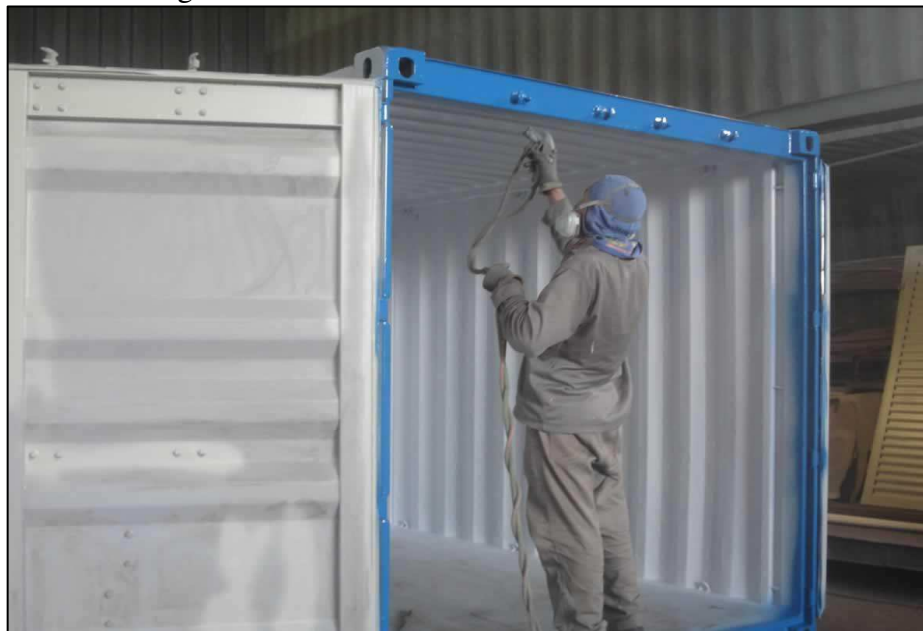
Figura 45 - Pintura sendo executada em contêiner
