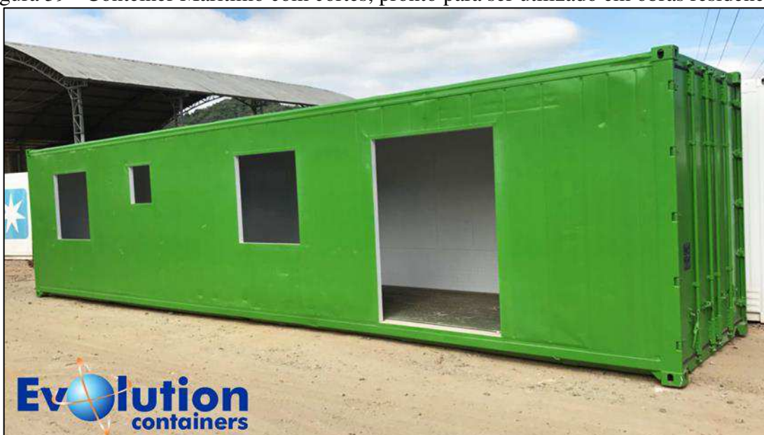
Figura 39 - Contêiner Marítimo com cortes, pronto para ser utilizado em obras residenciais
