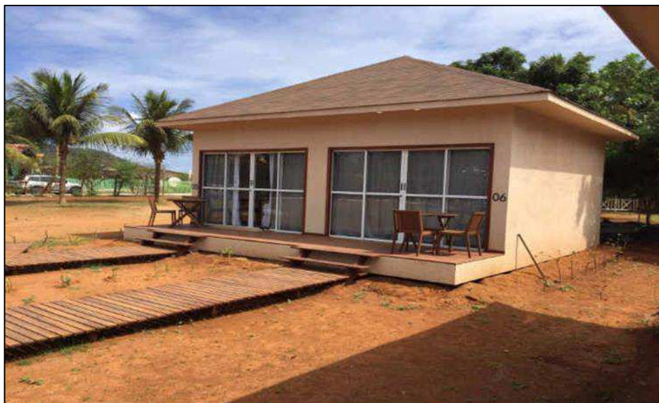
Figura 23- Pousada em Fernando de Noronha construída com o sistema Steel Frame
