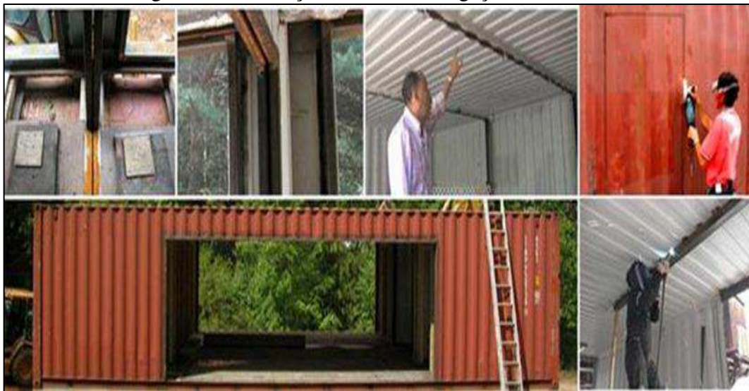
Figura 18 - Execução de Cortes e Ligações em Contêineres
