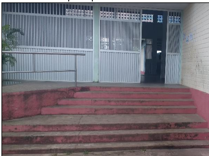
Figura 25 - Escada principal do Restaurante Universitário
