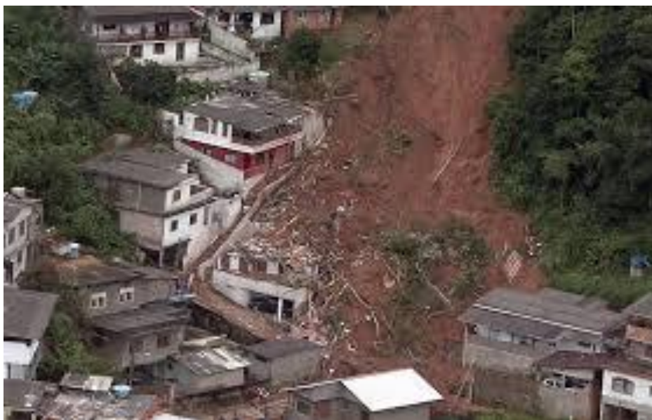
Figura 5 - Deslizamento de terra no Rio de Janeiro
