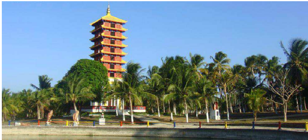
Figura 3 – Torre de sete andares
