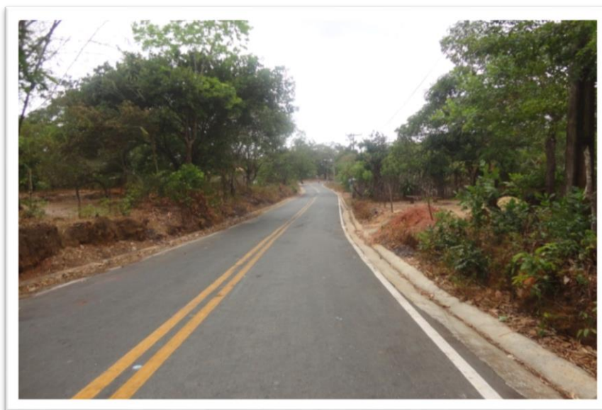
Foto 3 - Estrada de acesso ao Taim, com pavimentação asfáltica
