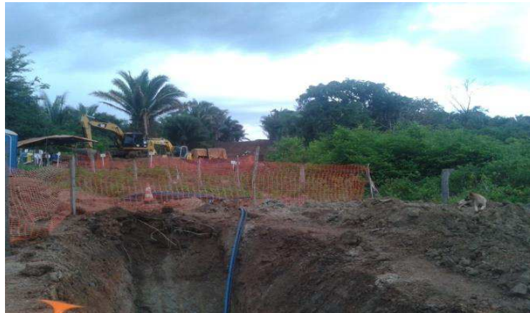
Figura 5: Visão parcial de uma das áreas onde foram aterrados os dutos que serão utilizados para o escoamento do gás.
