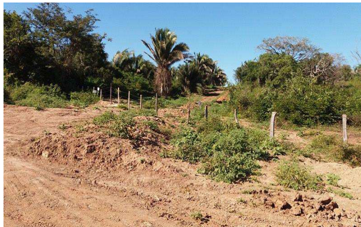
Figura 6- Visão da mesma área apresentada pela figura 7, após 4 meses do aterramento dos dutos.
