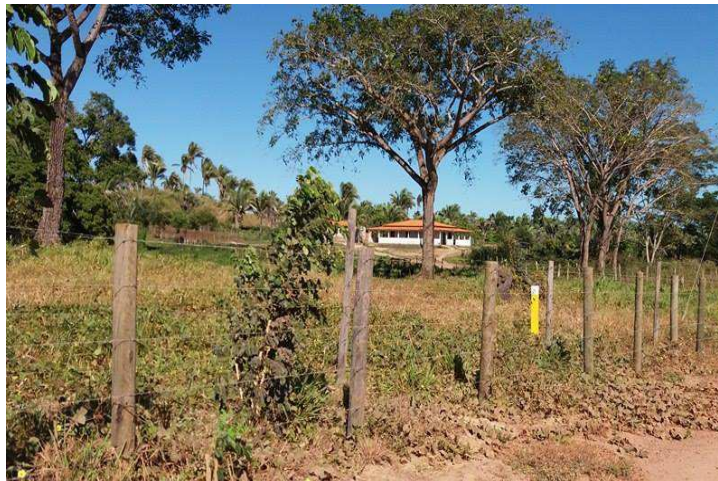
Figura 8- “Estacas” de dorso amarelo, extremidade branca com logotipo da empresa Parnaíba Gás Natural, utilizadas para sinalizar a passagem dos dutos aterrados.
