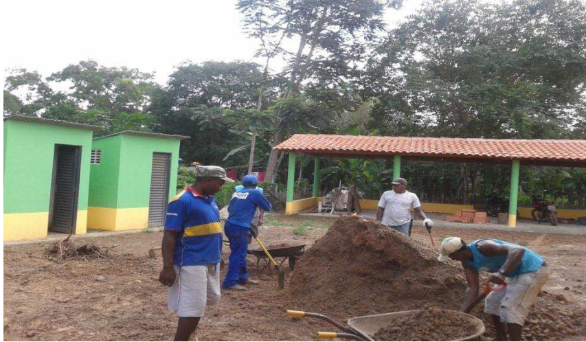
Figura 1 - Reforma da casa de farinha
