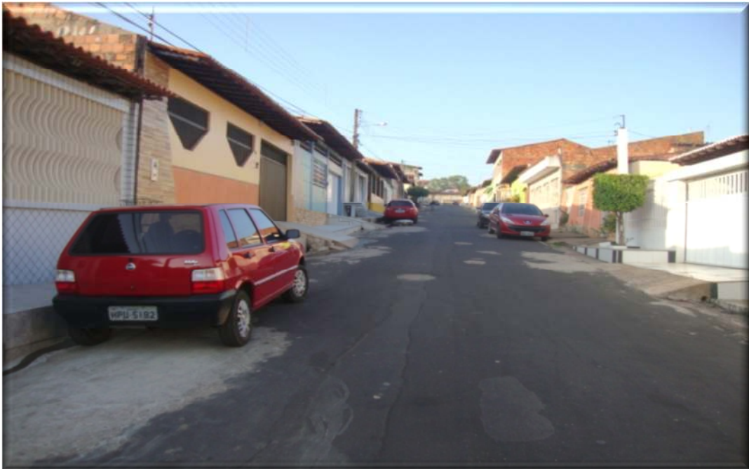
Foto 4: Conjunto Habitacional Bairro Angelim em São Luís – MA. Fonte: CUNHA, H.W.A.P, 2010.
