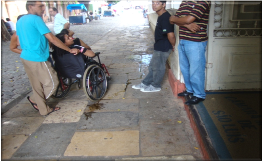
Foto 34: Entrada da câmara de vereadores com ausência de rampa/barreiras nas edificações. Fonte: CUNHA, H.W.A.P, 2010.
