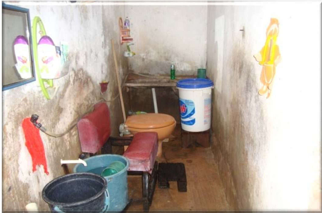
Foto 15: Banheiro sem nenhuma adaptação. Fonte: CUNHA, H.W.A.P, 2011.
