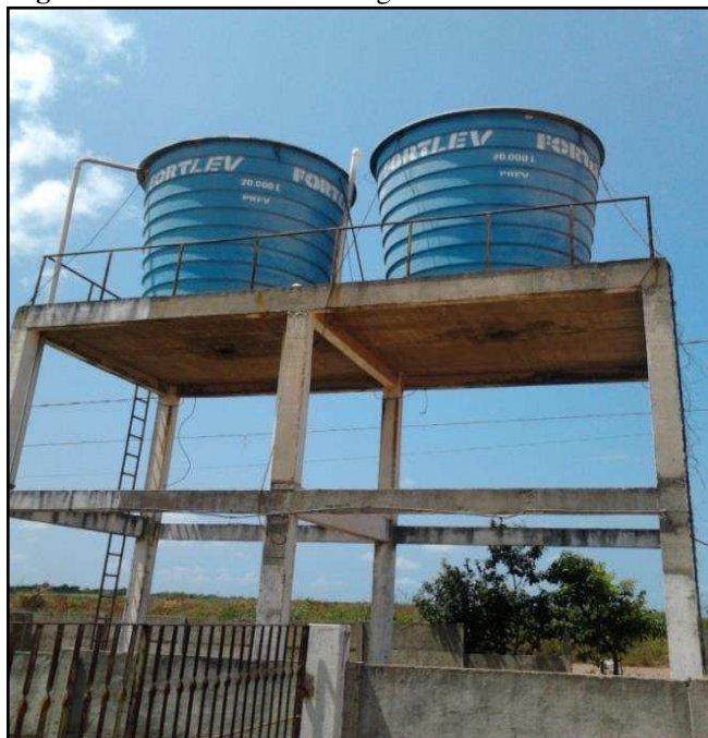
Figura 29: Abastecimento de água na Nova Canaã
