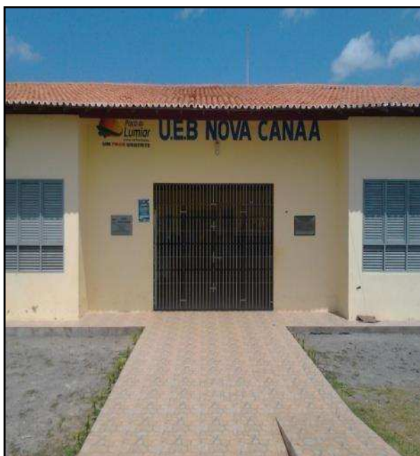
Figura 23: Vista frontal UEB Nova Canaã
