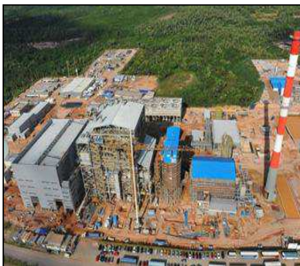
Figura 02: Canteiro de obra da UTE
