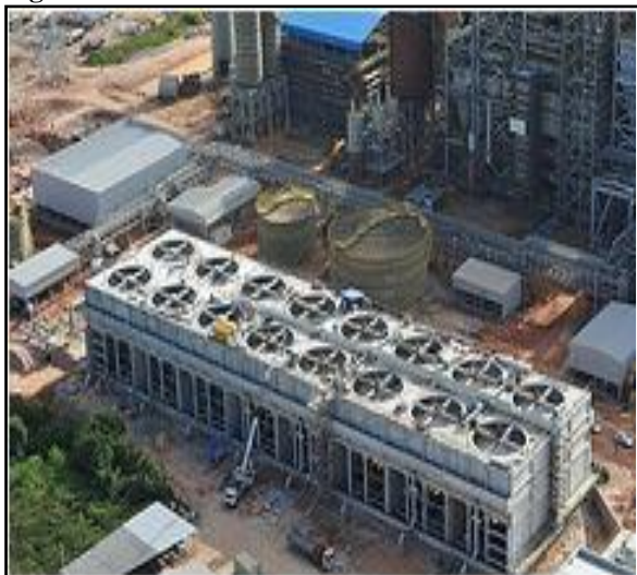
Figura 06: Torre de resfriamento da UTE
