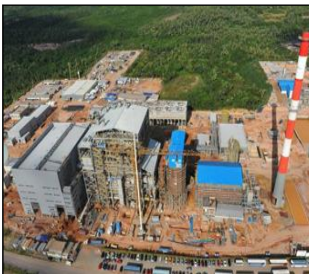
Figura 02: Canteiro de obra da UTE
