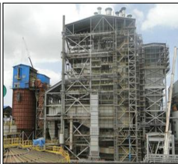
Figura 03: Prédio da turbina e caldeira da UTE
