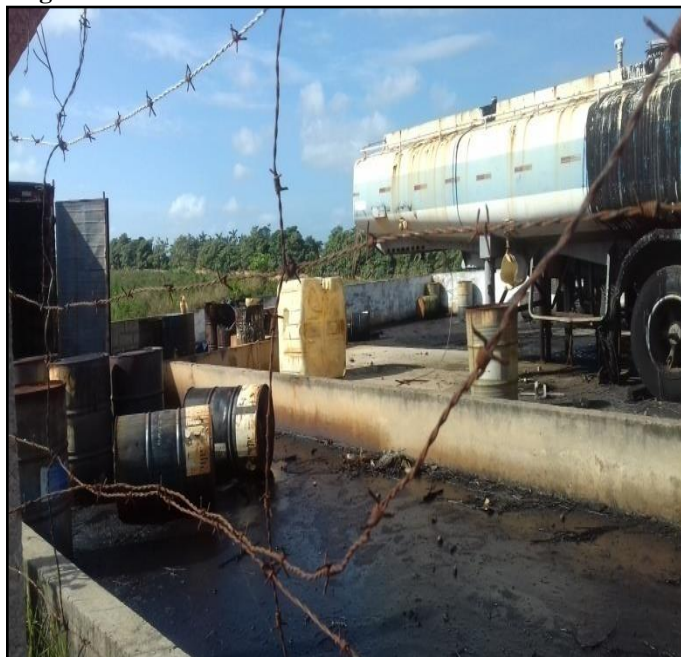
Figura 50: Restante da estrutura física da Fábrica de Asfalto
