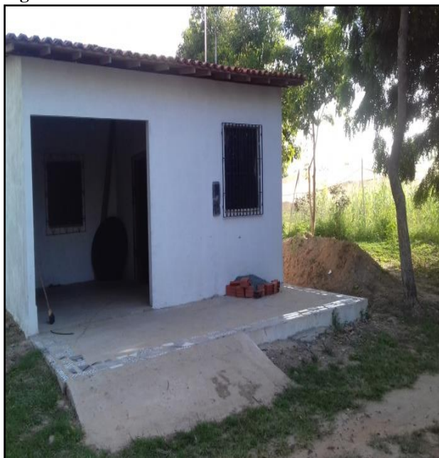
Figura 46: Casa construída no interior do Pólo
