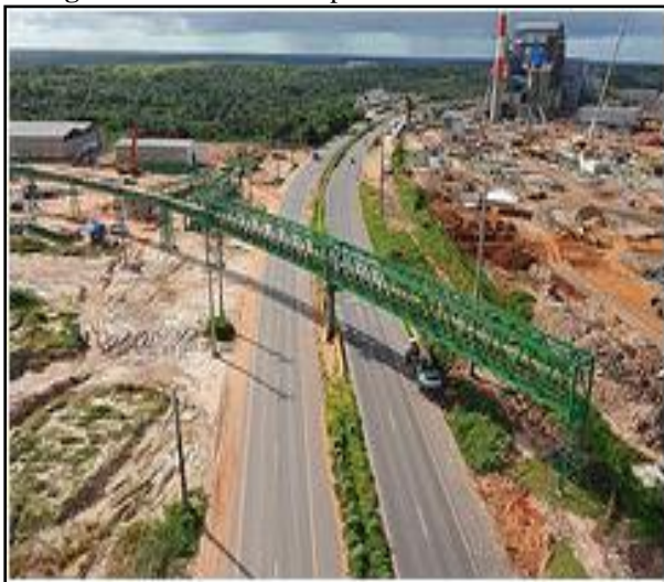
Figura 07: Correia transportadora da UTE
