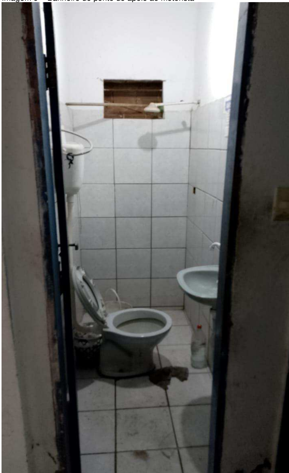
Imagem 6 – Banheiro do ponto de apoio ao motorista
