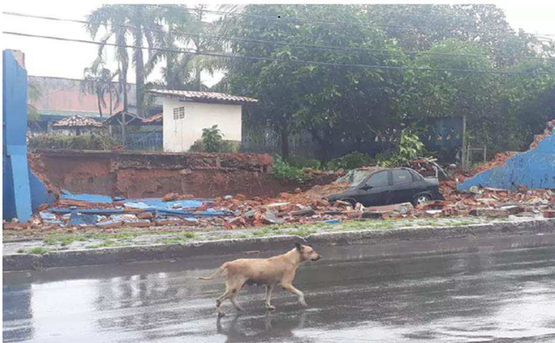
Figura 13 Prejuízos causados por desabamentos
