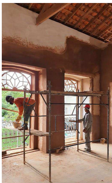
Figura 41 - Imagem do restauro do Centro Caixeiral.
