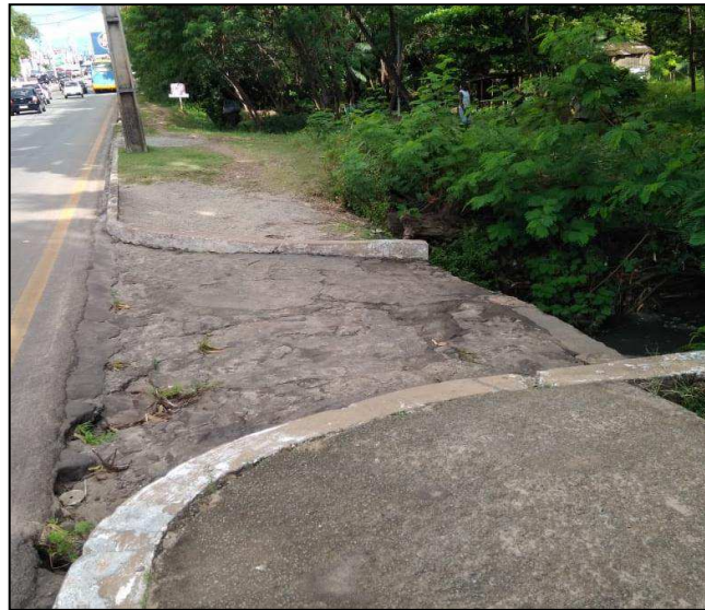
Figura 44: DA-12 – Descida d'Água
