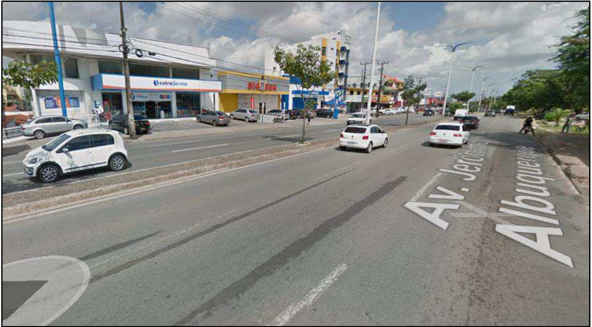
Figura 26: Vista do trecho inicial de estudo – região da curva do Noventa
