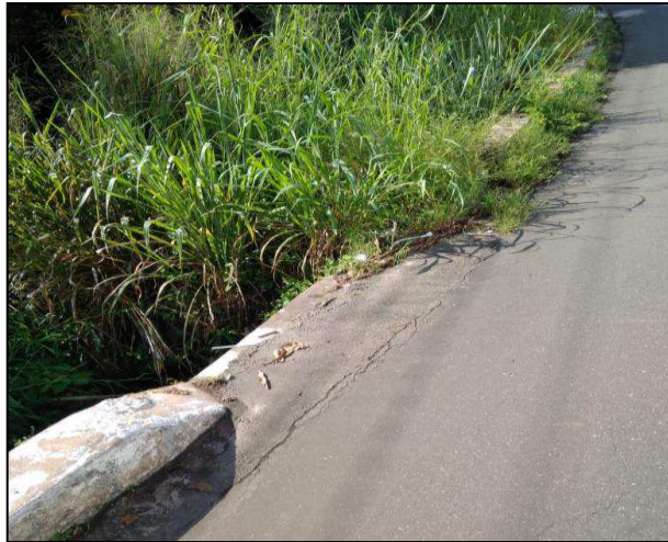
Figura 40: DA-08 – Descida d'Água
