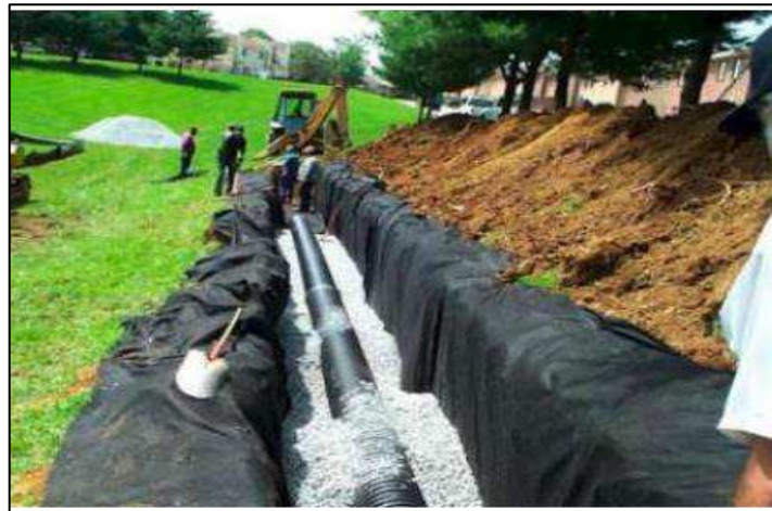
Figura 16: Trincheira de percolação
