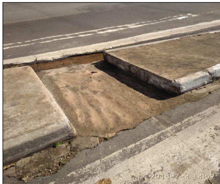
Figura 35: DA-02 – Descida d'Água
