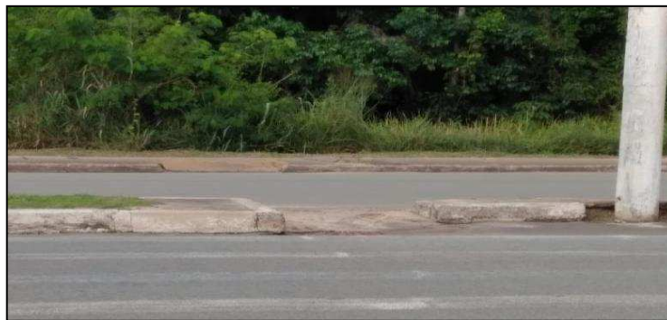
Figura 39: DA-07 – Descida d'Água
