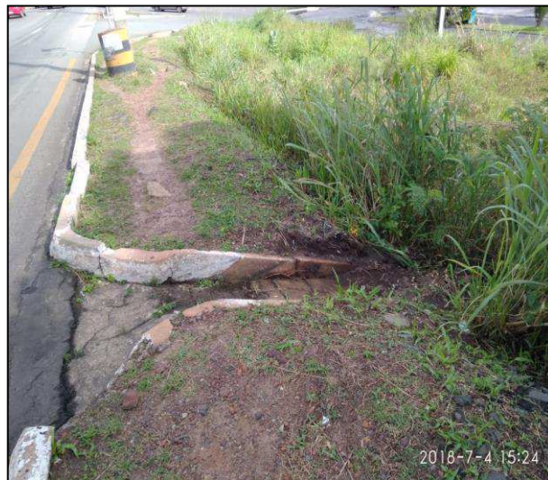
Figura 43: DA-11 – Descida d'Água
