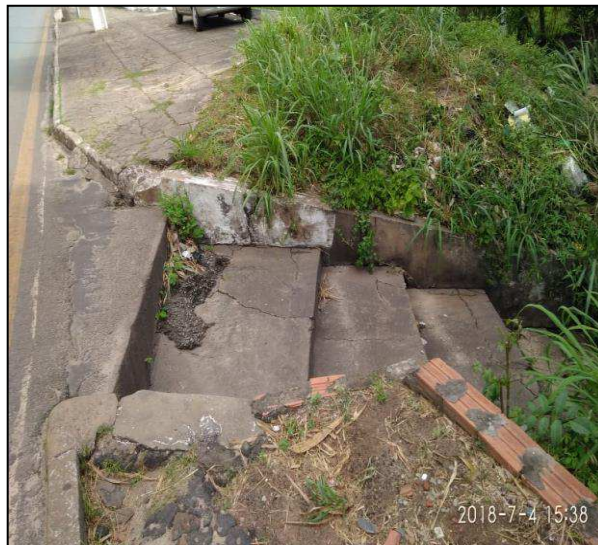
Figura 46: DA-14 – Descida d'Água
