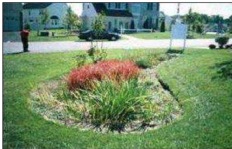
Figura 15: Superfície de infiltração
