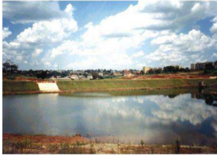
Figura 22: Bacia de detenção
