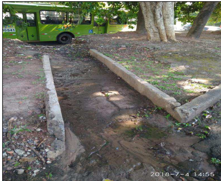
Figura 34: DA-01 – Descida d'Água
