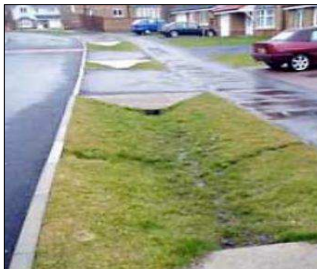
Figura 17: Vala de infiltração
