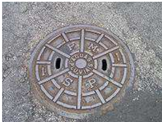
Figura 11: Poço de visita
