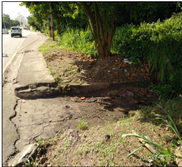
Figura 41: DA-09 – Descida d'Água
