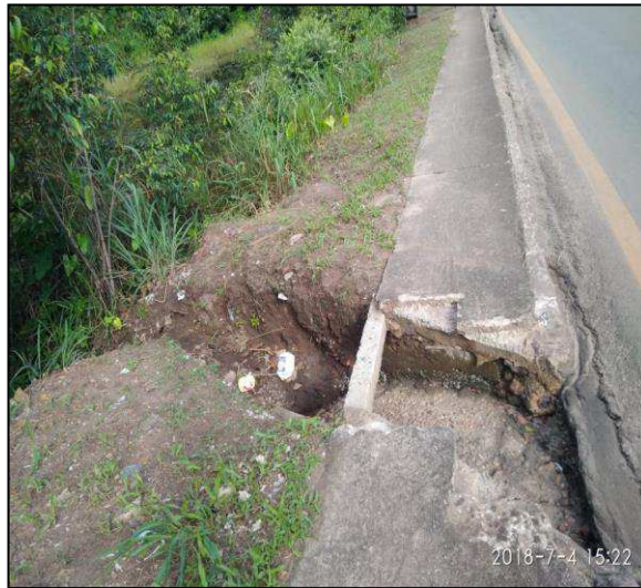
Figura 42: DA-10 – Descida d'Água
