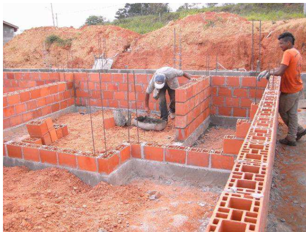
Figura 19 – Alvenaria Estrutural de Bloco Cerâmico
