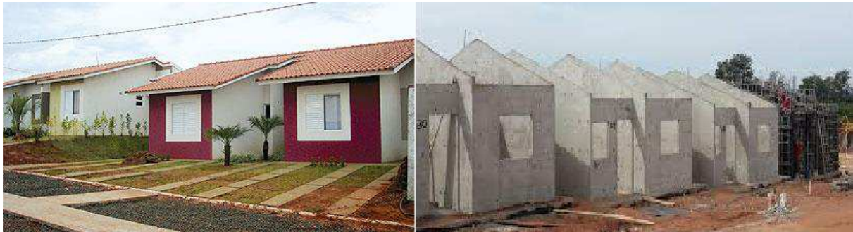
Figura 3 – Sistema Construtivo em Parede de Concreto
