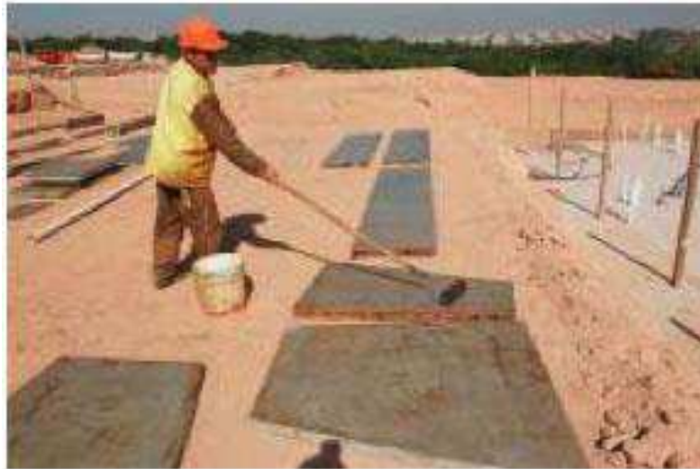
Figura 16 – Aplicação de Desmoldante
