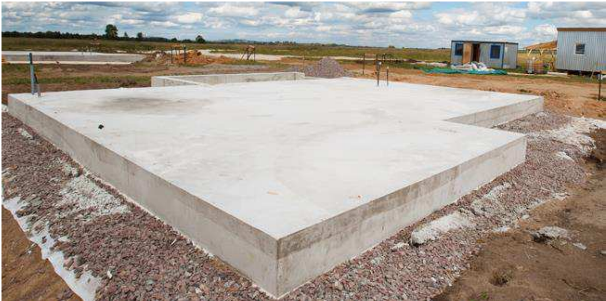
Figura 7 – Fundação em Radier
