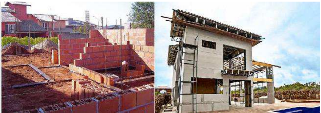
Figura 4 – Sistema Construtivo Alvenaria Estrutural de Bloco Cerâmico
