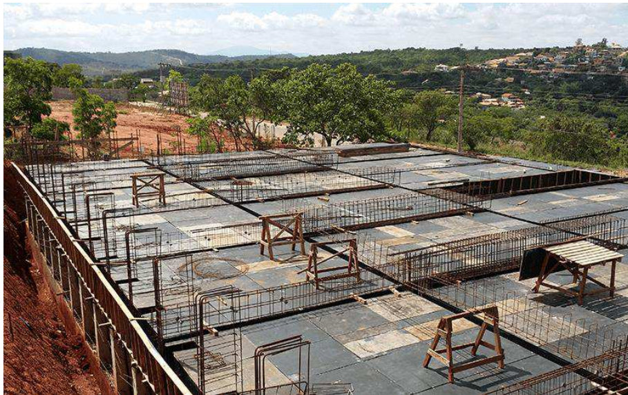
Figura 17 – Fôrmas das Lajes
