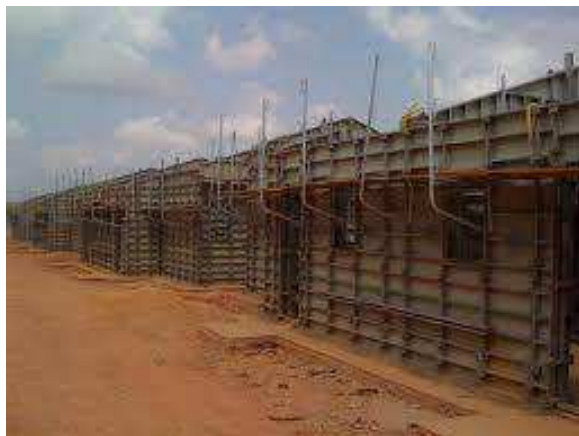
Figura 5 – Casas em Parede de Concreto
