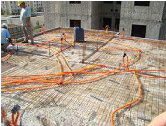
Figura 14 – Instalações Elétricas
