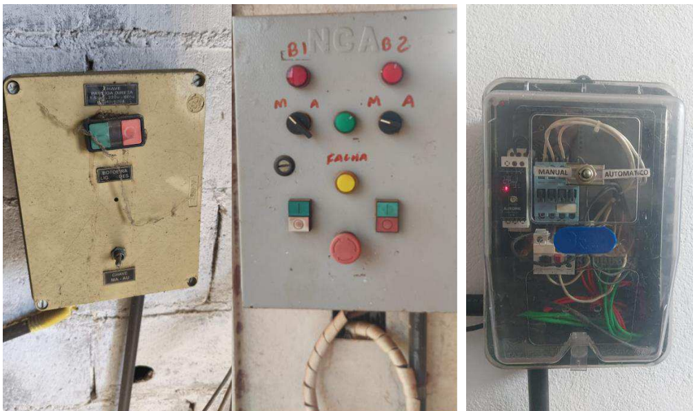
Figura 3-Quadro de incêndio
