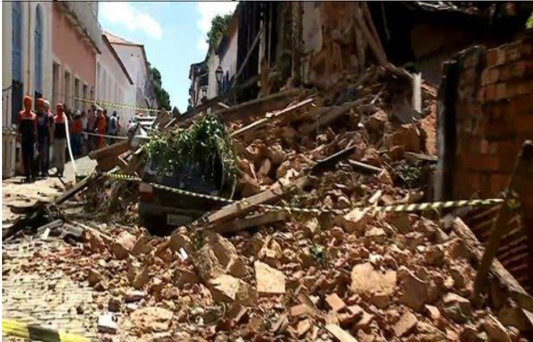
Figura 7: Casarão desabou e atingiu carro na rua do Giz, no bairro do Desterro
