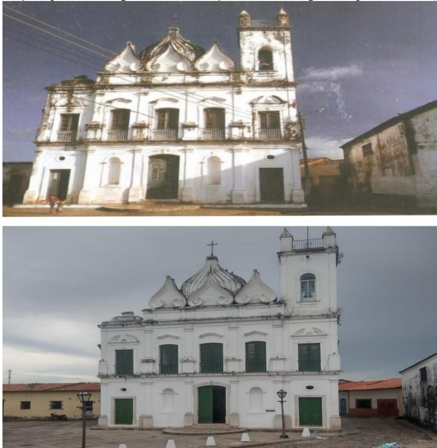
Figura 8: Igreja São José do Desterro nas décadas de 1970 (com fiação aparente) e 2020 (sem fiação aparente, Largo com novo calçamento e com gradis e postes baixos)
