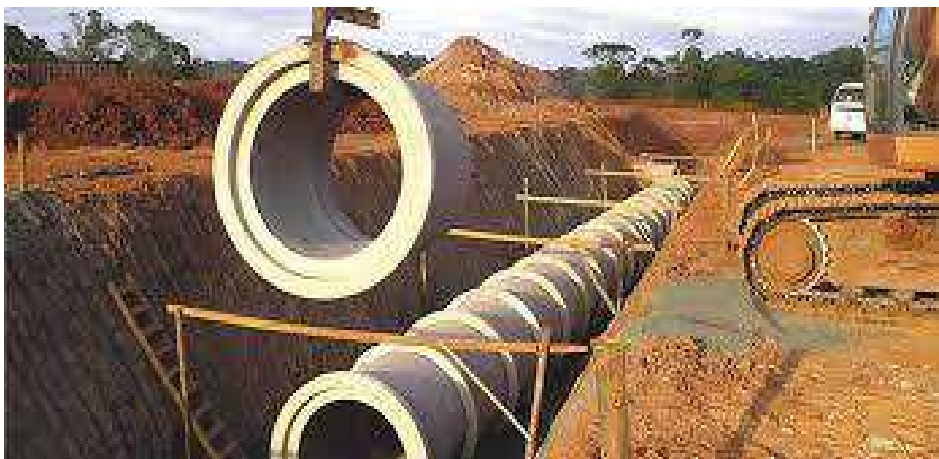
Figura 10 - Instalação de galerias
