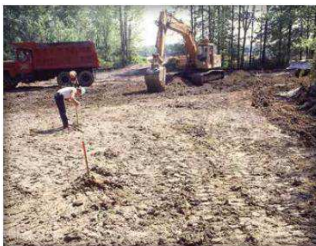
Figura 25 - Escavação do solo
