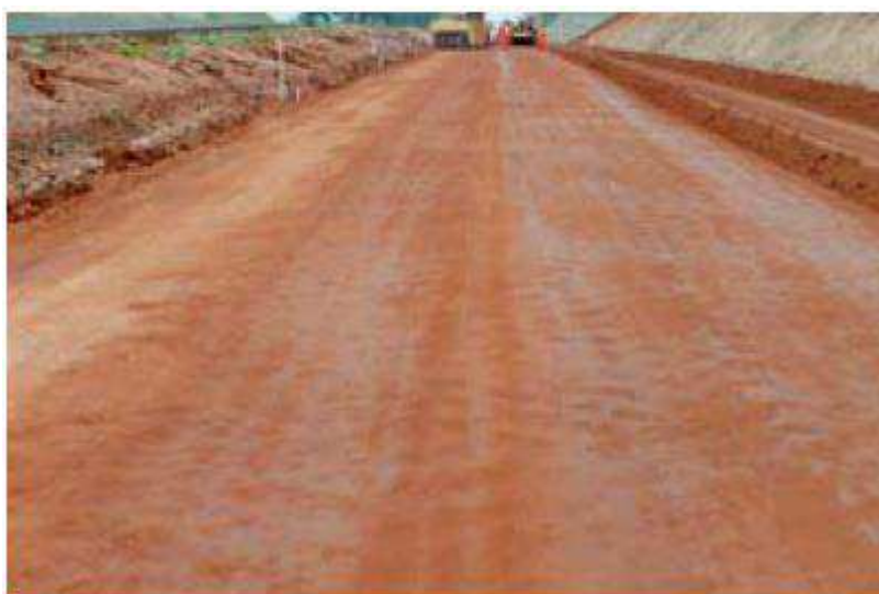
Figura 26 - Compactação do subleito
