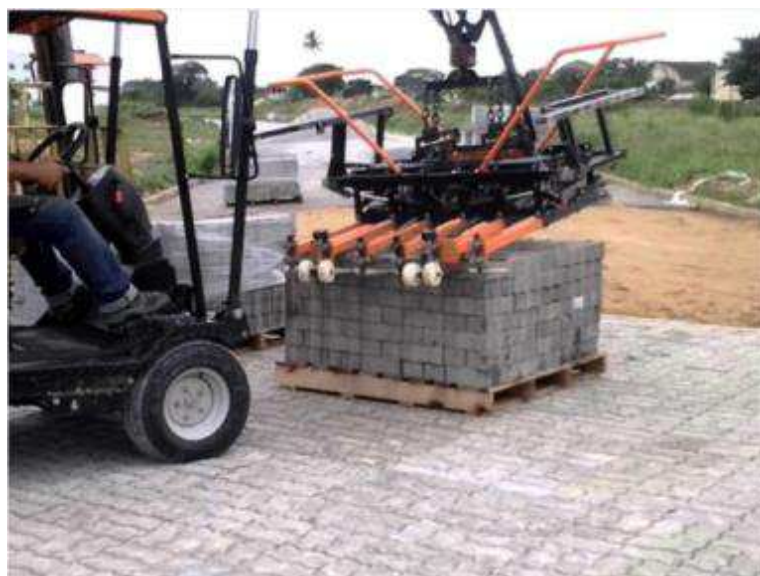
Figura 29 - Pavimentadora automática de paver (2)
