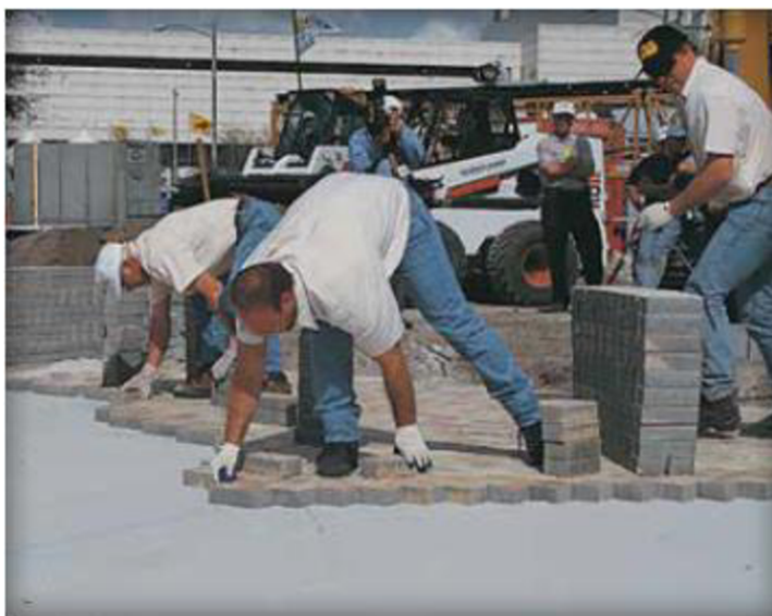
Figura 30 - Assentamento manual das PPC
