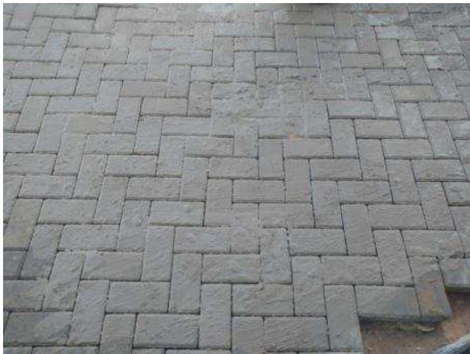
Figura 62 – Argamassa aplicada para preenchimento das juntas
