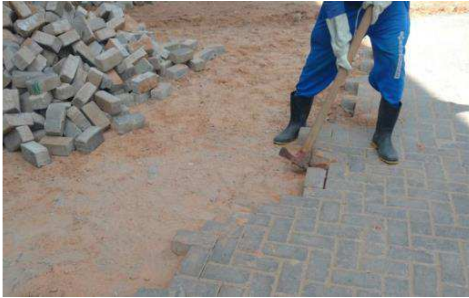
Figura 59 – Retirada das PPC
