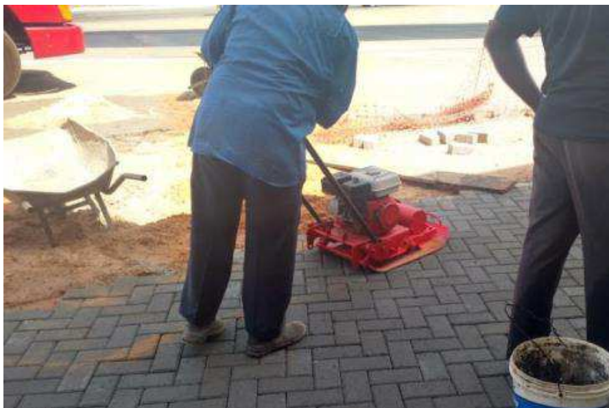
Figura 60 – Compactação do pavimento
