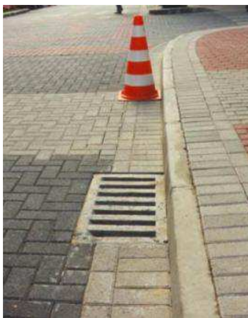
Figura 27 - Confinamento externo (meio fio)
