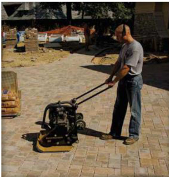
Figura 31 - Compactação dos blocos
