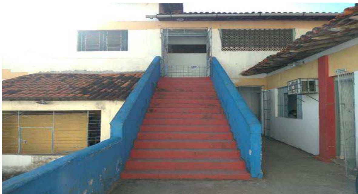
Figura 6- Escadaria que dá acesso ao andar de cima por fora do Centro de Ensino Gonçalves Dias (Arquivo pessoal, 2022)
