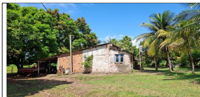
Figura 7. Casa de Apoio da FESB Fonte: Arquivo Pessoal (2025).
