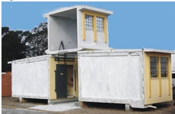
Figura 6 – Estrutura dos módulos
