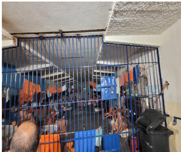
Figura 29 – Pavilhão denominado de Fundão – dividido em blocos
