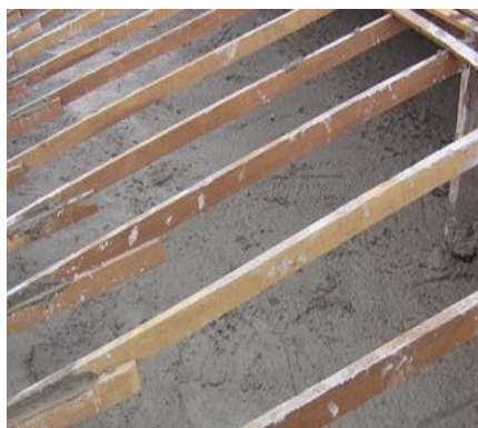
Figura 12 - Novo recapeamento de concreto na UPSL 4 – após evento de fuga pelo teto
