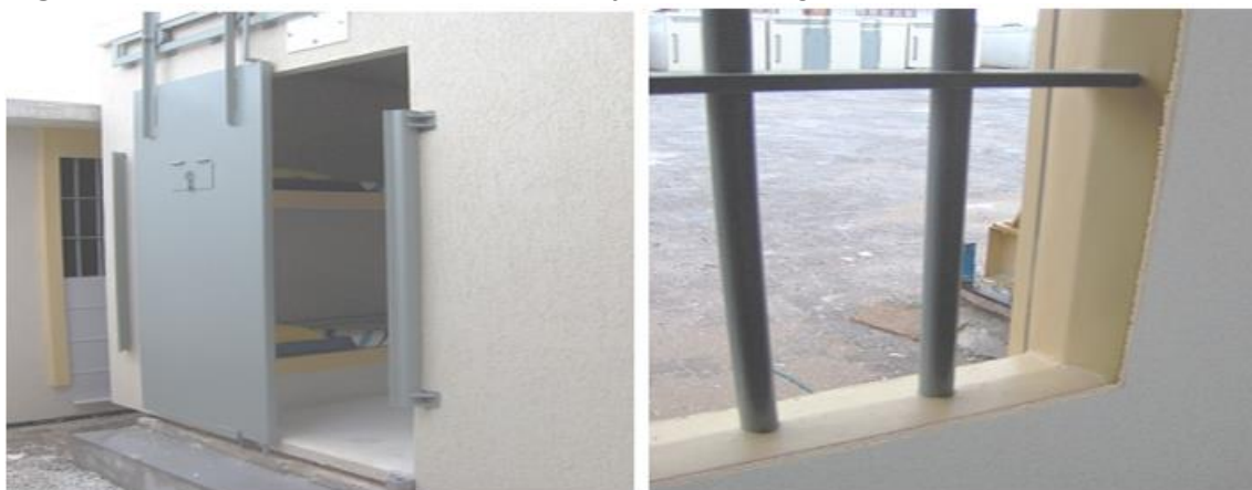
Figura 2 - Porta de módulo de cela chumbada já na concretagem.
