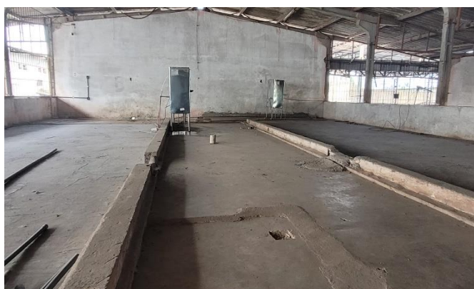
Figura 33 - O teto das celas sendo substituído por laje na UPLS 2 e 3
