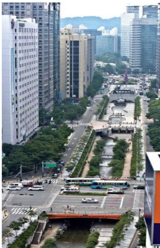
Figura 4: Revitalização do rio Cheonggyecheon
