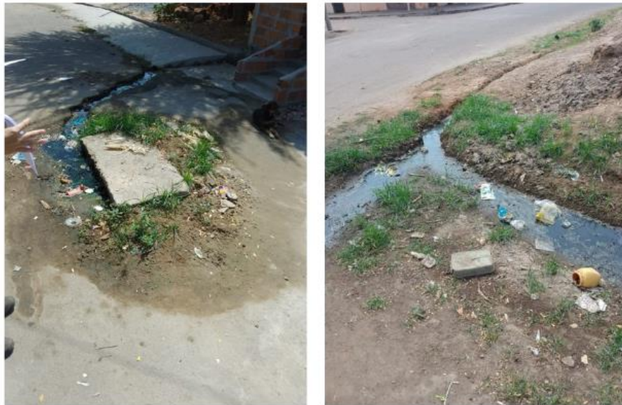
Figura 14: Situação dos pontos de drenagem e sarjetas das ruas do bairro Trizidela.
