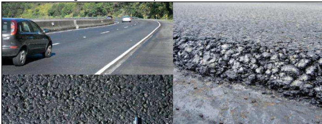
Figura 8 – 2006: SMA aplicado na BR 277 - Paraná.
