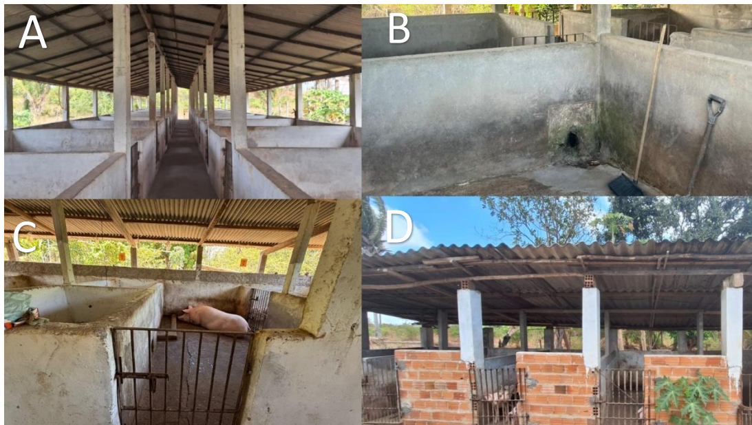
Figura 2. Estruturas físicas das granjas suinícolas da Grande Ilha do Maranhão.
