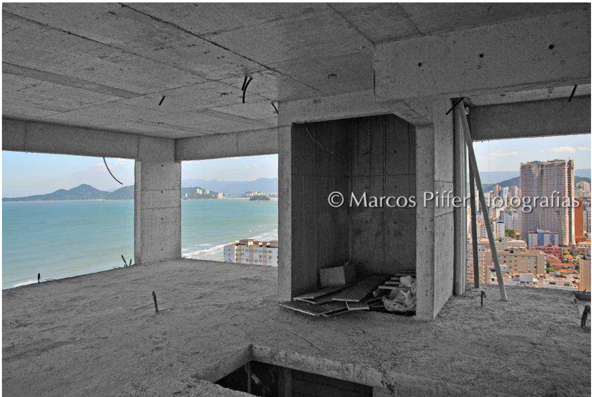
Figura 12 – Pilar parede e núcleo estrutural
