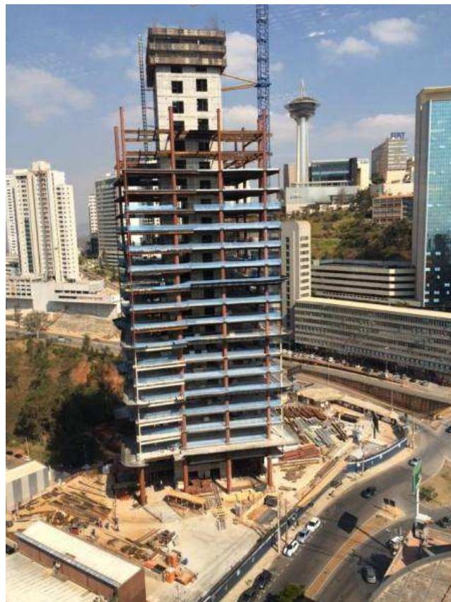
Figura 15 – Construção de edifício contraventado por núcleo
