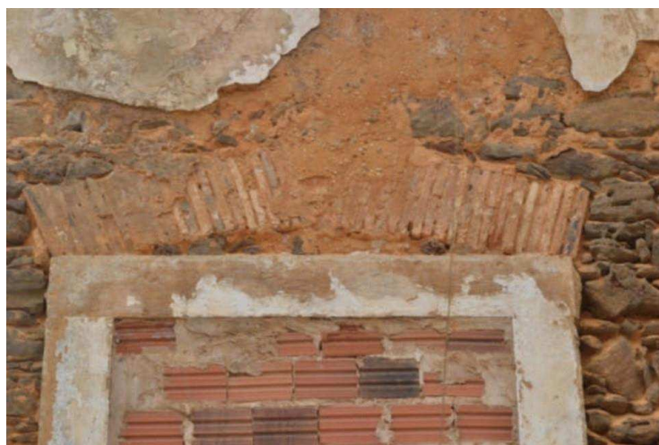
Figura 10:Tijolos cerâmicos presentes em arcos de edificações pombalinas de São Luís.
