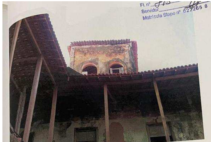
Figura 59: Varanda com estrutura restaurada e o mirante.
