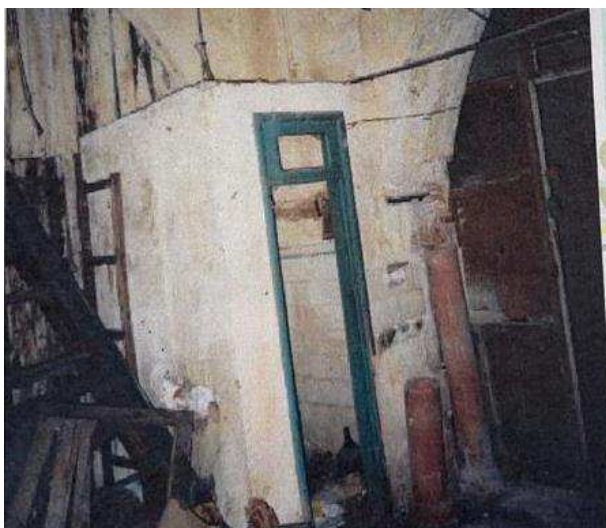
Figura 55: Banheiro coletivo construído no térreo.
