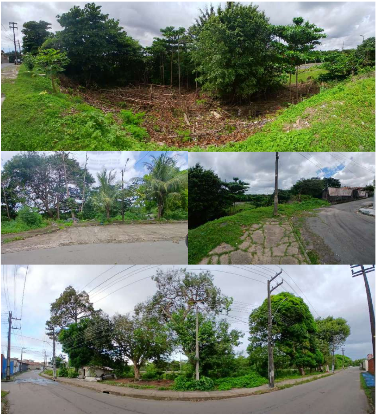
Figura 24 – Exemplos de infraestruturas presentes no Parque Amazonas em situação de abandono
