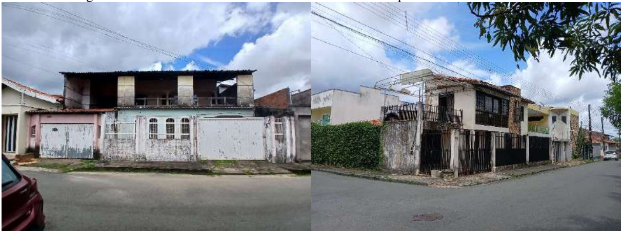
Figura 16 – Imóveis abandonados localizados em diversos pontos no interior do bairro
