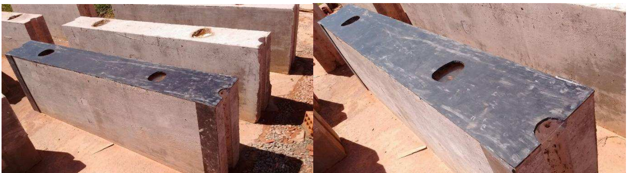
Figura 11: Viga Pré-Moldada Ensecadeira
