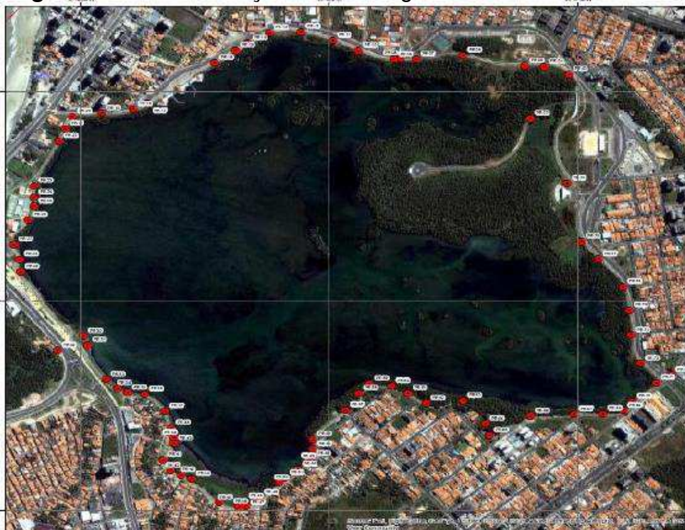
Figura 5: Pontos de lançamento de esgoto
