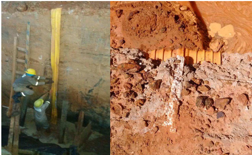
Figura 8: Junta de dilatação Fugenband
