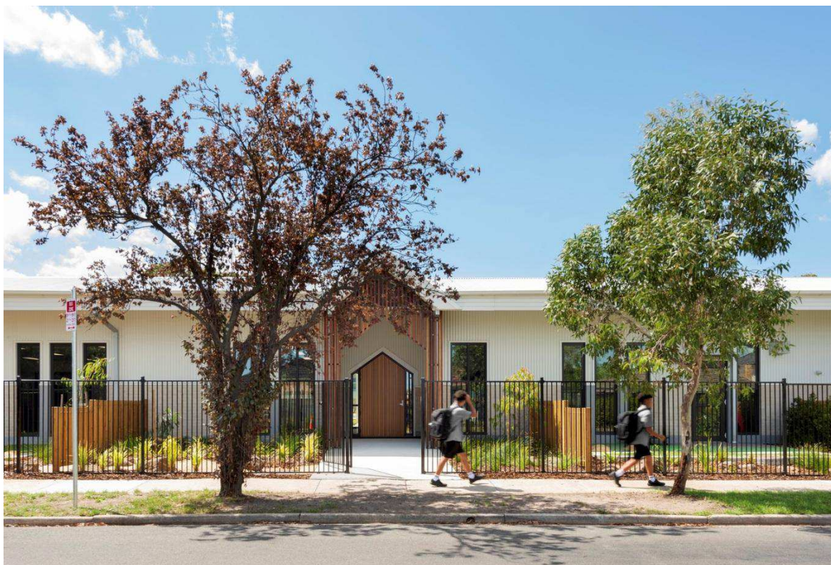
Figura 6 - Fachada principal da escola Niddrie, Austrália
