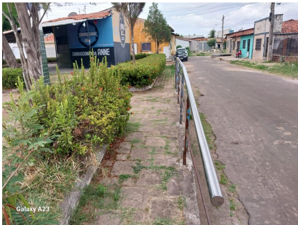
Figura 20 - Rampa de Acesso estreita (rua Firmino Neto)
