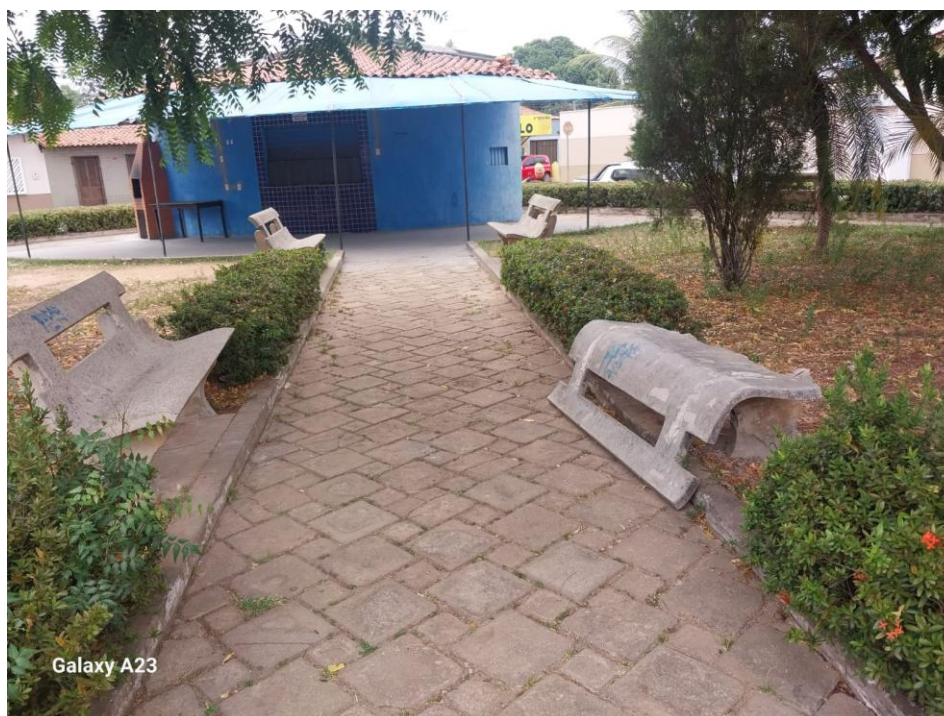
Figura 41- Assentos públicos deteriorados
