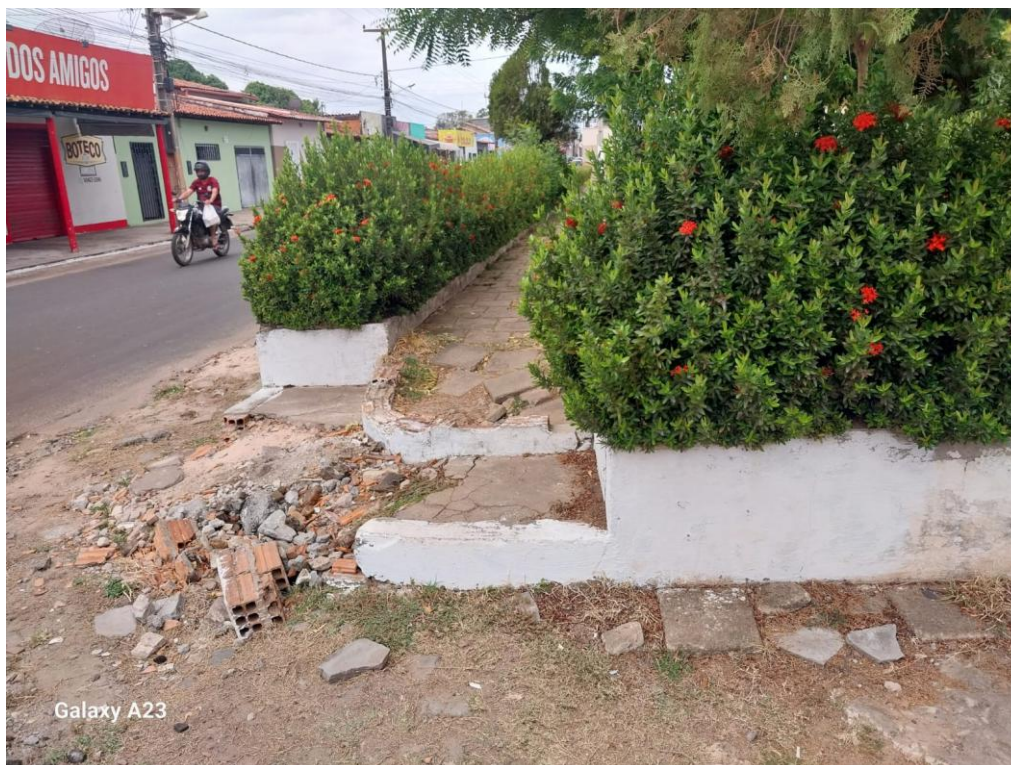
Figura 9 - Exemplo de Guia de Acesso (rebaixamento da calçada)
