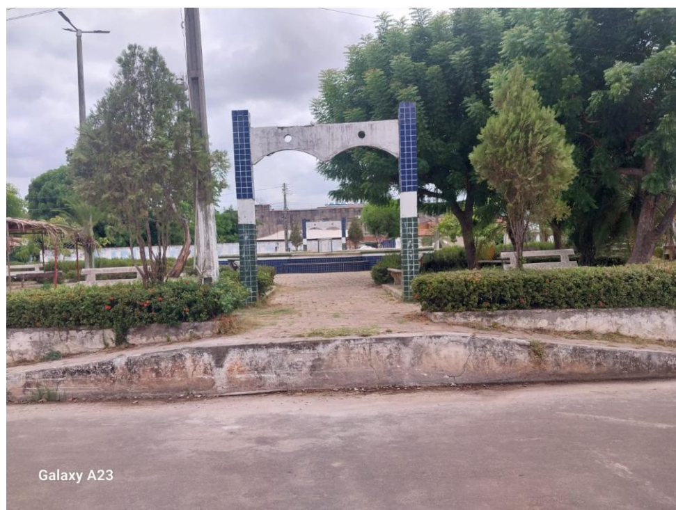
Figura 18 - Exemplo de Rampa de Acesso na praça Firmino Neto (Travessa Firmino Neto)
