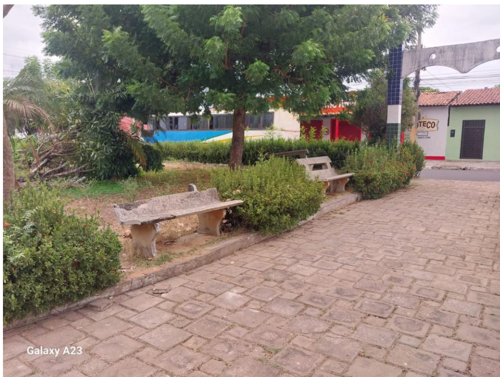
Figura 42 - Assentos públicos deteriorados
