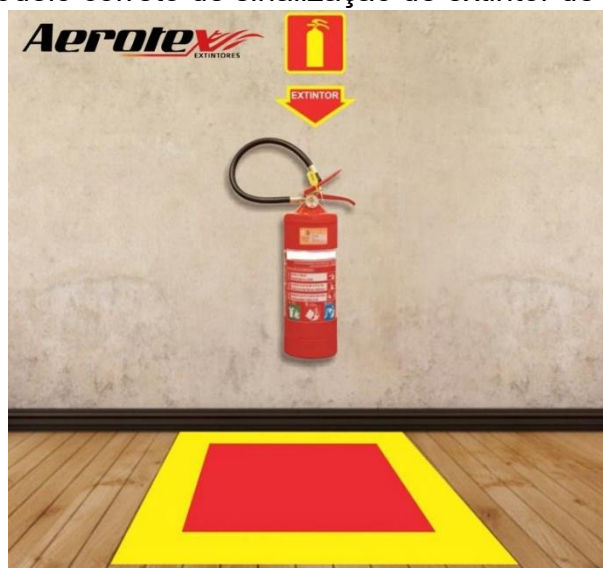
Figura 15 - Modelo correto de sinalização de extintor de incêndio
