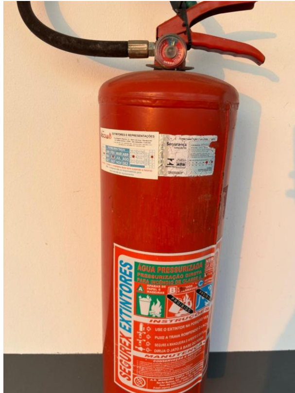
Figura 17 - Extintor de incêndio de água
