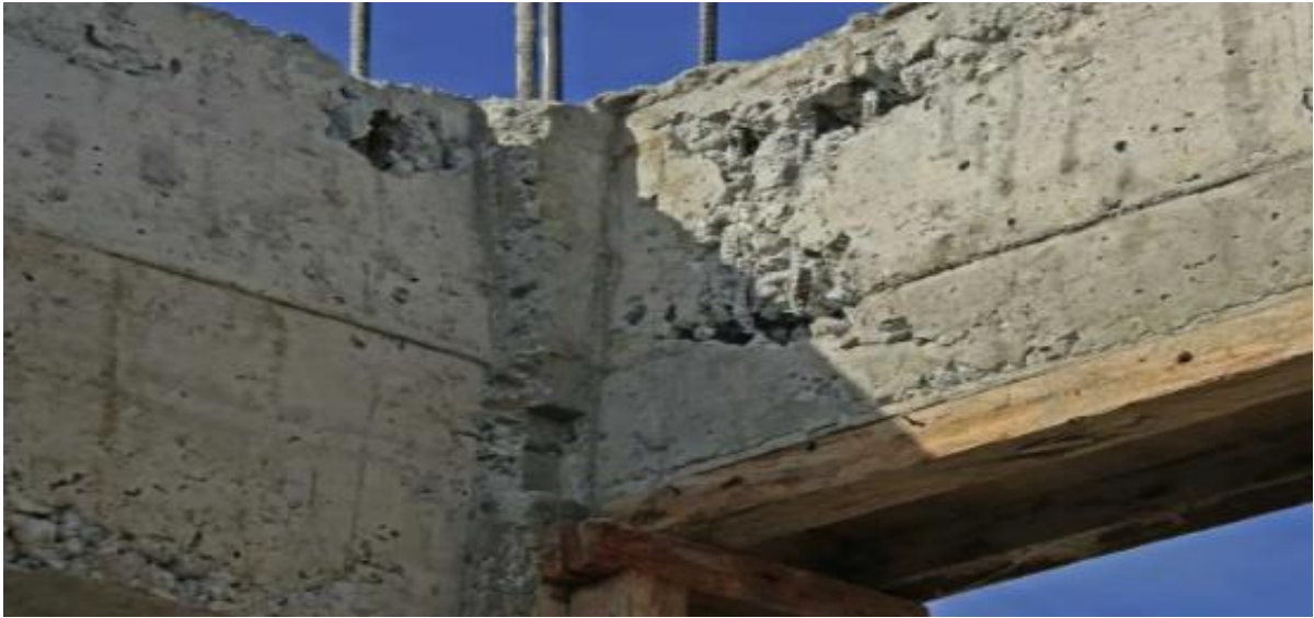
Figura 6 - Concreto segregado
