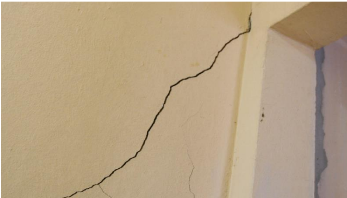
Figura 4 – Fissura térmica
