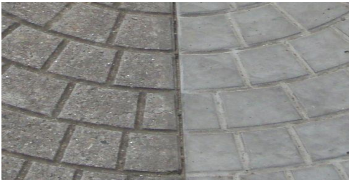
Figura 2 - Desgaste causado por abrasão
