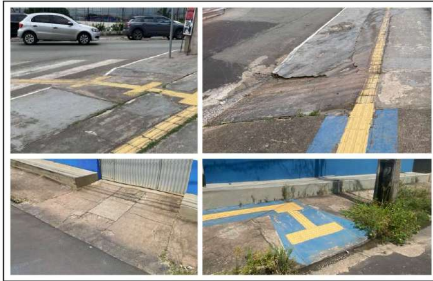
Figura 17 - Rebaixamentos na calçada da Travessa Bequimão
