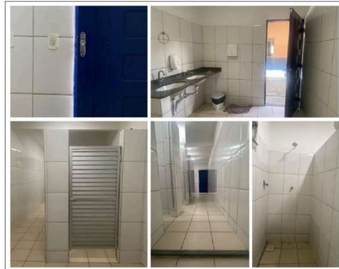
Figura 30 - Banheiro coletivo feminino
