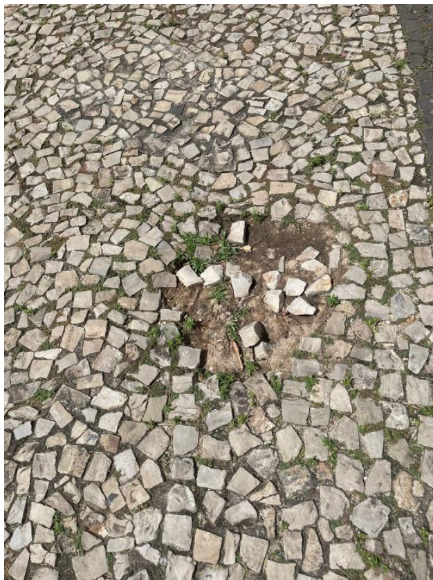
Figura 10: foto (B) detalhe de calçada do trecho 1
