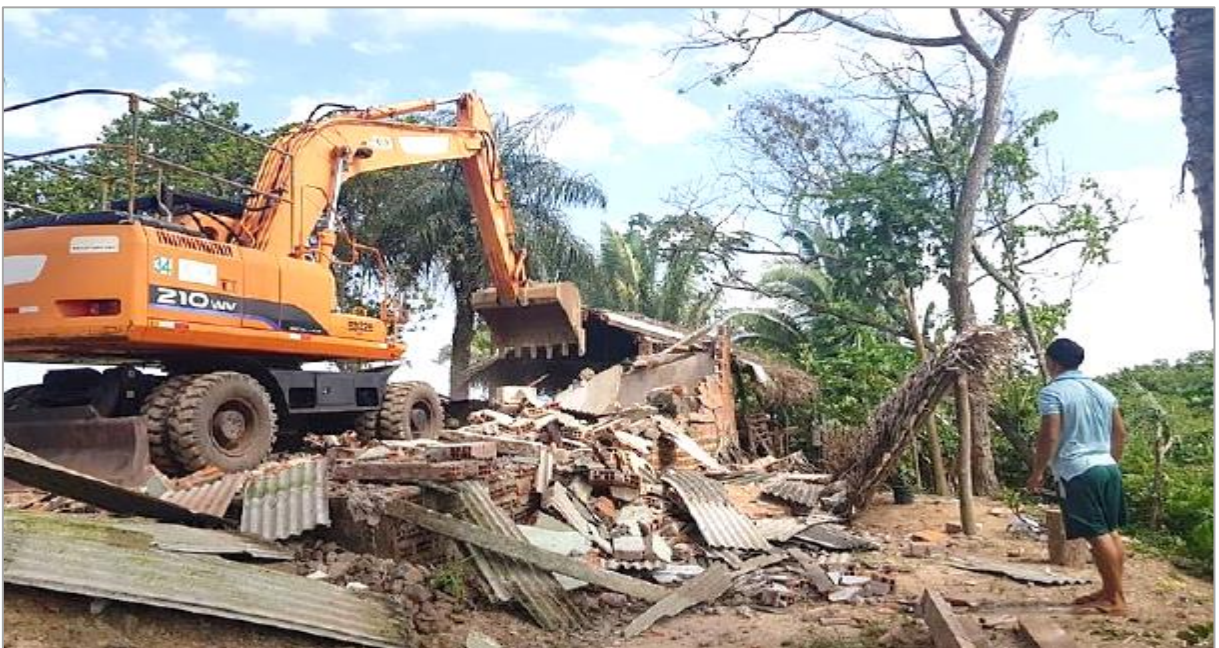
Figura 7 – Cajueiro, São Luís-MA: demolição de moradia em área reclamada pela WPR
