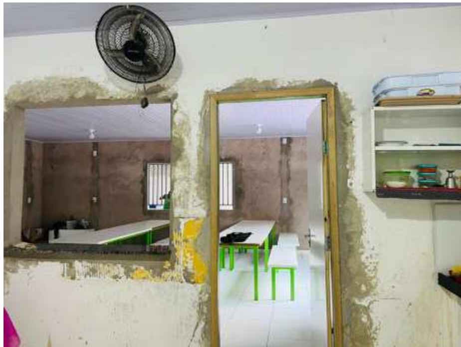
Figura 7 - Registro Fotográfico da realização da reforma na escola
