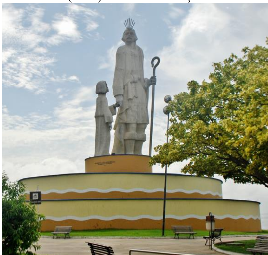
Figura 37 – Monumento de São José de Ribamar (Bolo) antes da interdição
