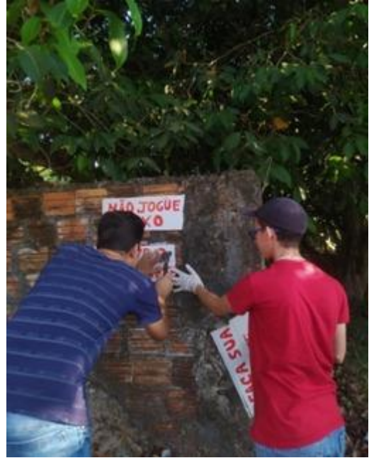
Instalação de placas educativas no ponto 12 de infraestrutura com os voluntários da UEMA. Autoria: Everton, 2024.
