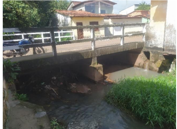
Figura 6: Ponte com guarda-corpo sobre o rio Velha Bárbara no Ponto 12
