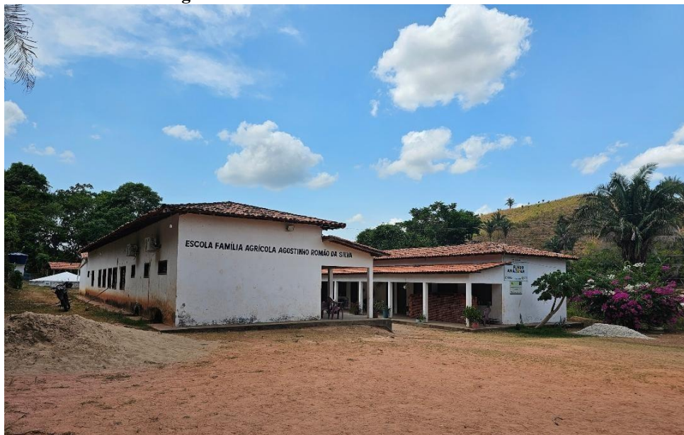
Figura 5 — Fachada da Referida escola
