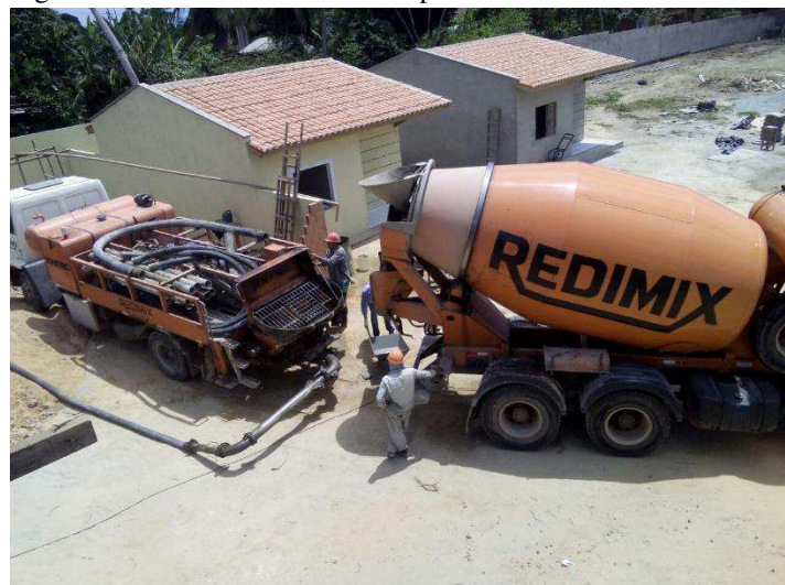
Figura 7 - Caminhão betoneira acoplado à bomba estacionária
