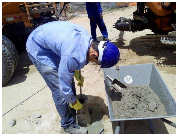
Figura 11 - Operacionador adensando o concreto
