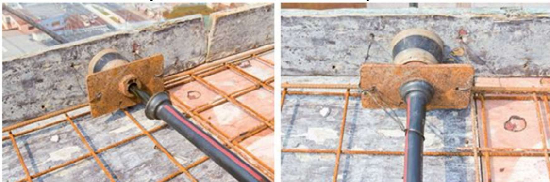
Figura 27 – Fixação da cordoalha na ancoragem ativa
