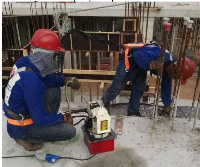
Figura 29 – Operação de protensão dos cabos
