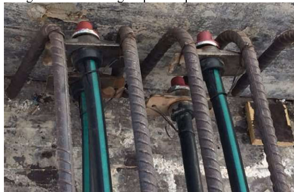
Figura 17 – Ancoragem passiva por meio de cunhas
