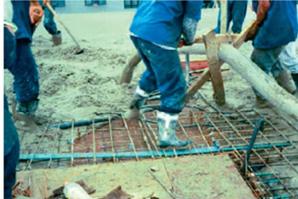
Figura 28 – Concretagem de laje lisa protendida
