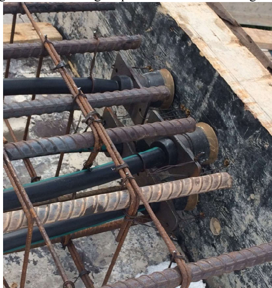
Figura 14 – Ancoragem para monocordoalha engraxada
