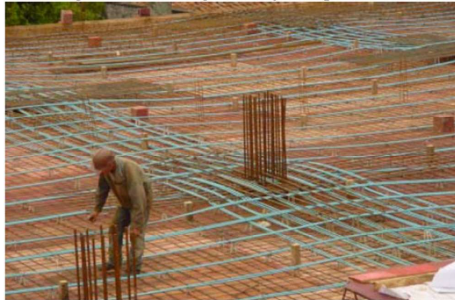
Figura 25 – Montagem de laje lisa protendida
