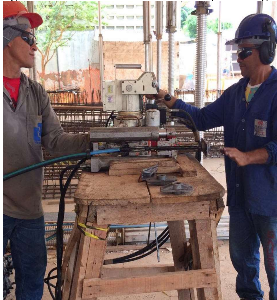
Figura 18 – Macaco hidráulico durante pré-blocagem
