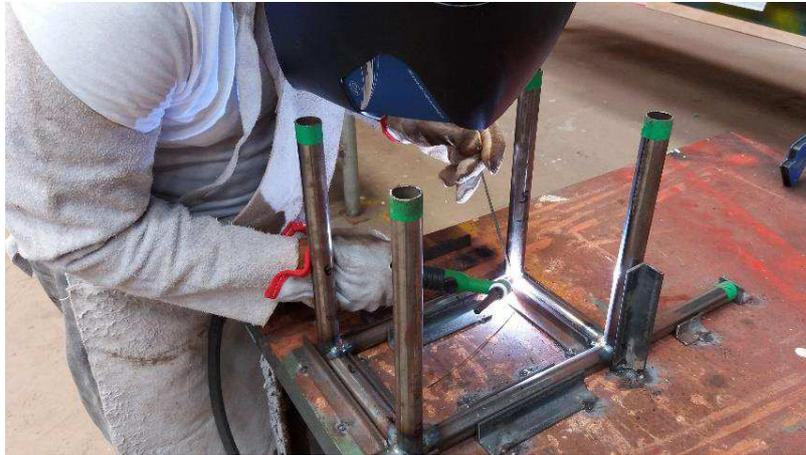
**Figura 3.21 - Soldagem da Estrutura Tubular**
