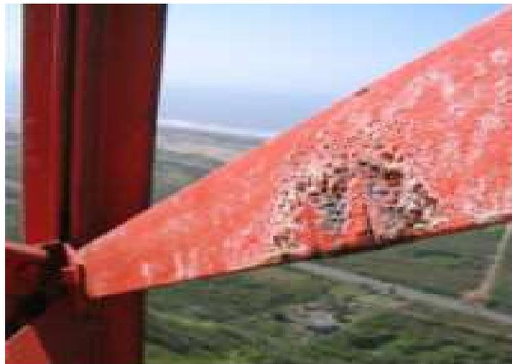
Figura 2 - Corrosão na parte superior da torre
