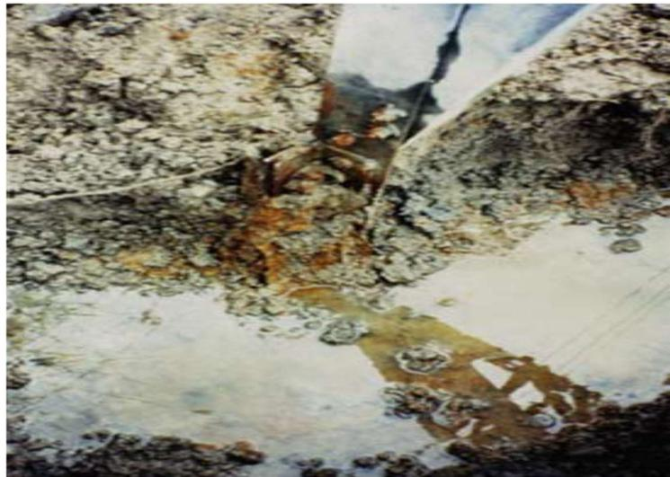
Figura 1 - Corrosão na base da torre
