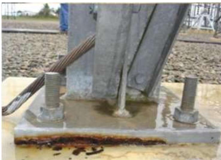
Figura 18 - Corrosão por fresta
