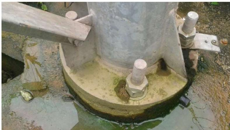
Figura 32 – Flange sujeito a acúmulo de água
