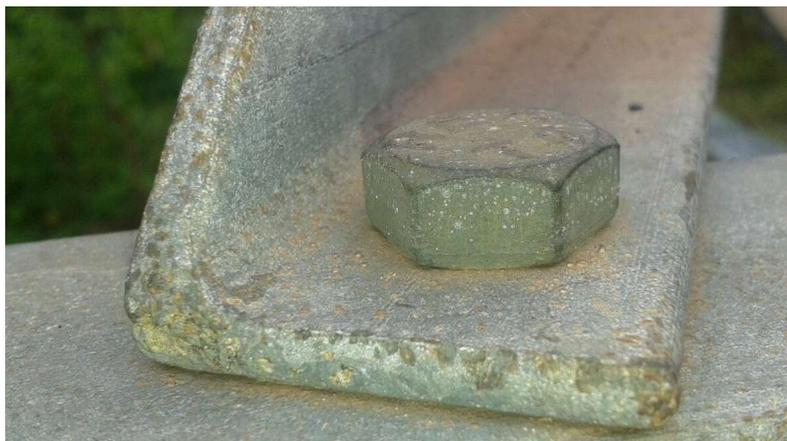
Figura 34 - Contato entre parafuso e cantoneira
