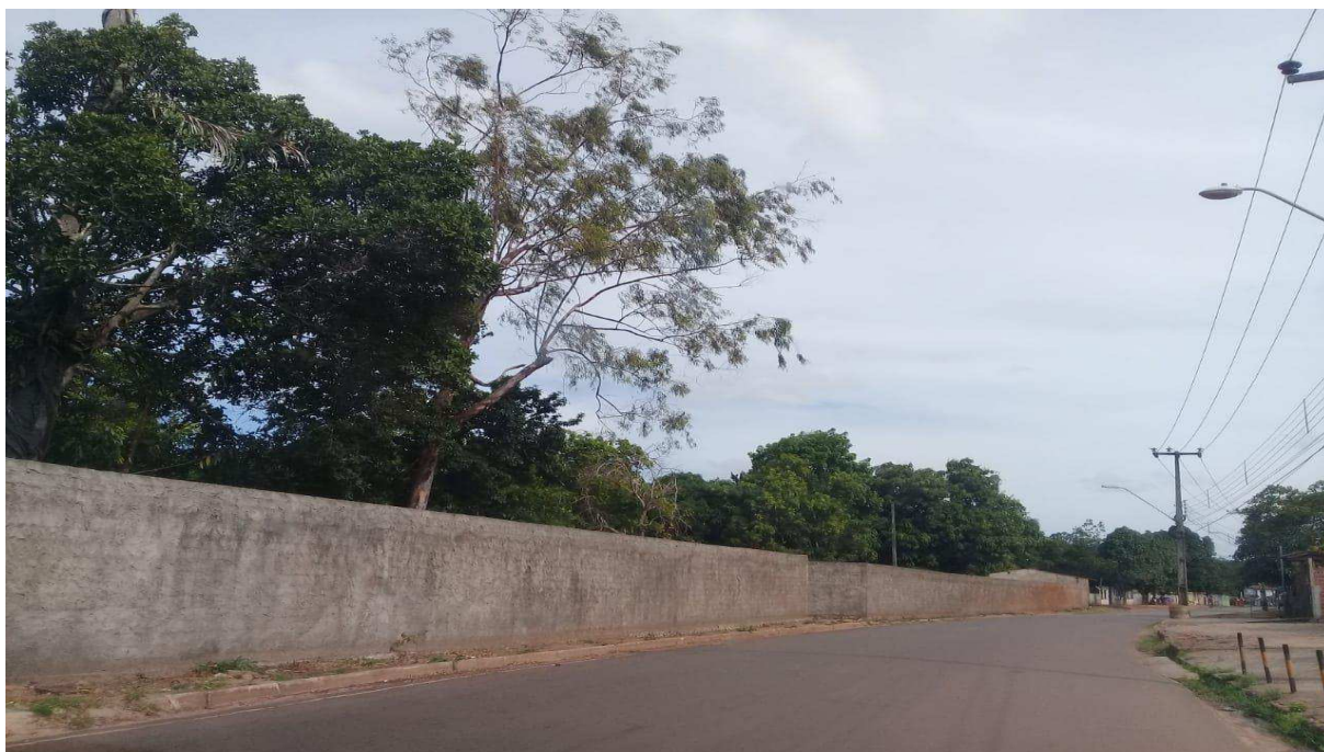
Figura 15 - Muro de uma casa construída na comunidade do Maracanã. Fonte: Carla Souza.
