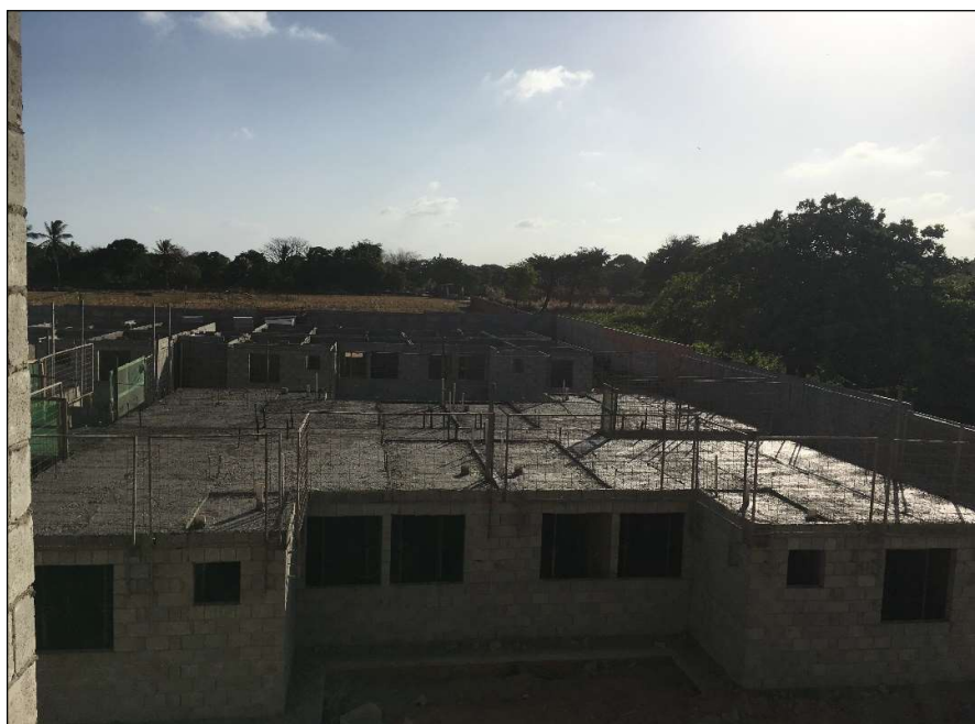
Figura 1 Exemplo de Guarda-corpo com rodapé
